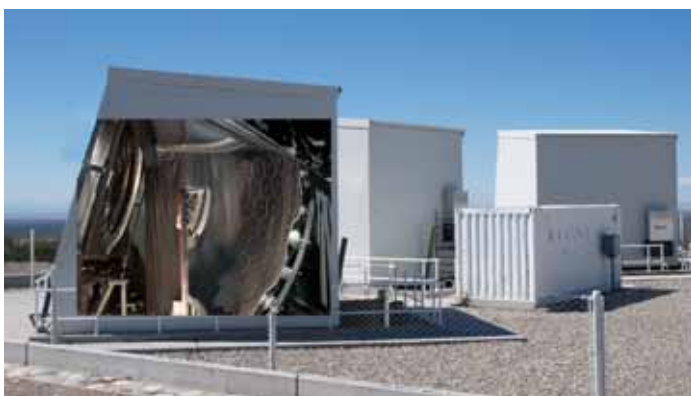
■ Obr. 7 Umístění optického systému teleskopu HEAT v klimatizovaném boxu.
