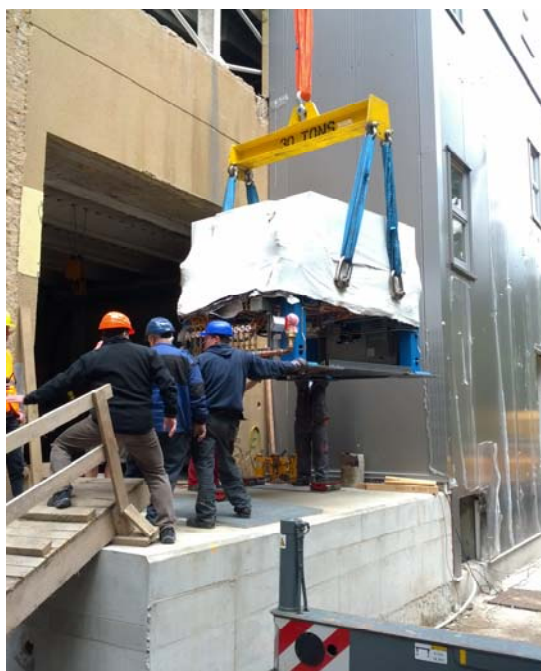
Přemístění a spuštění cyklotronu TR 24 do suterénu nové budovy.
