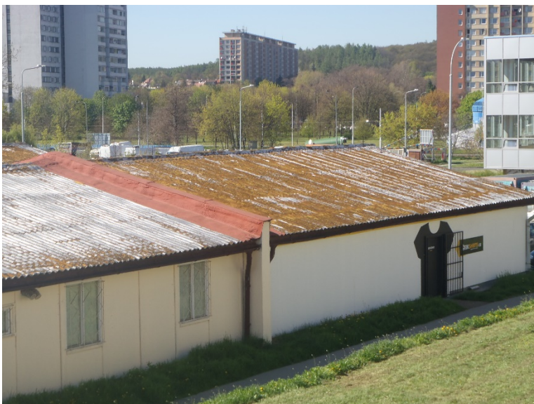
Foto č. 3: Detail střechy objekt Tesko C
