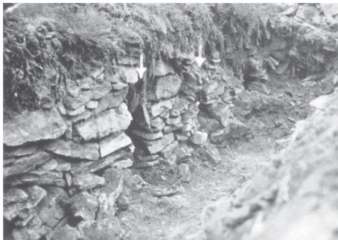
Abb. 3: Freilegung der Pfostenschlitzmauer in Trísov in den 30er Jahren des 20. Jahrhunderts (nach Franz 1942).
