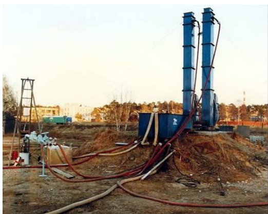
Obr. 3. Kolona s tahokovem odstraňující kontaminanty z podzemních vod v lokalitě Neptun, Bylany.
