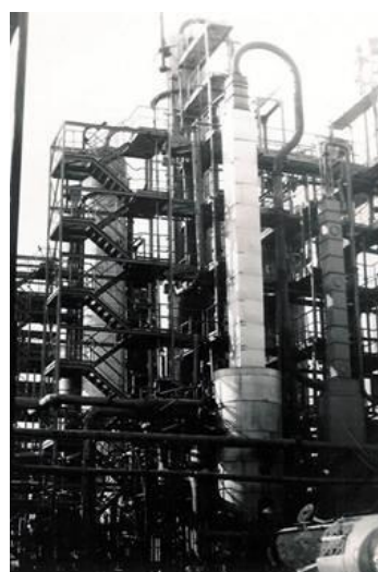
Obr. 2. Kolona s náplní z tahokovu. v tlakové plynárně Vřesová.
