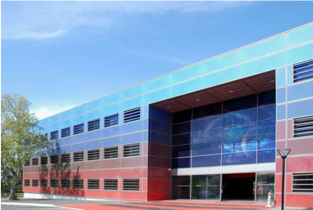
Figure 7.1 – The new building of Laboratoire d'Astrophysique de Marseille (LAM, France).
