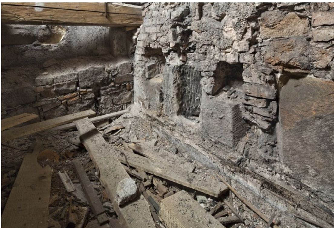
[4] Gotické zdivo na severní straně kostela – dole kvádrové zdivo s okénkem a zbytky shořelého fabionu dnešní Tadeášky, nad ním otisk klenby.
