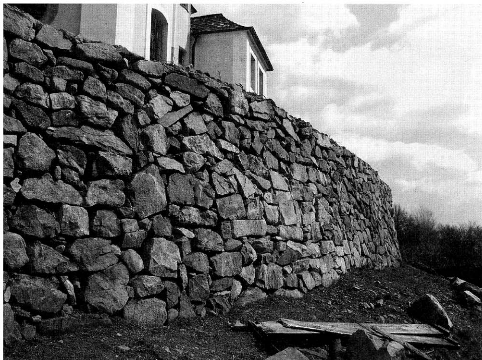
Obr. 5. Maková. Detail nasucho kladené kamenné zdi.
