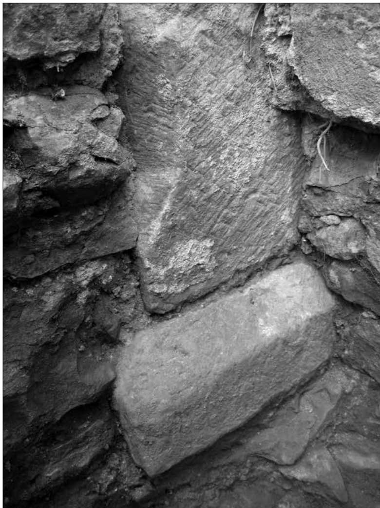
Foto 10: Jezbořice (okr. Pardubice), kostel sv. Václava. Sonda IV. Detail patky gotického dveřního ostění ve zdi přístavby na jižní straně kostela (zdivo 4902). Foto J. Frolík.
