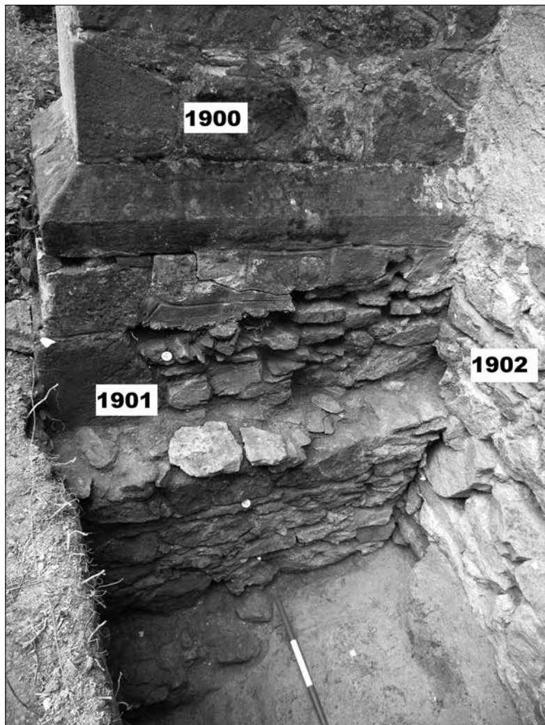
Foto 3: Jezbořice (okr. Pardubice), kostel sv. Václava. Sonda I. Vpravo zeď 1902, k níž je dodatečně přizděn opěrák (základ 1901, nadzemní zdivo 1900). Pohled od západu. Foto P. Pinc.
