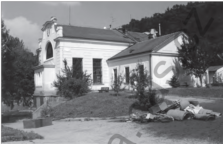
Budova tzv. Vodárny po vstupu do objektu Archivu AV ČR. Výška povodňové vlny je patrna nad okenními parapety podlaží v úrovni pouliční komunikace (A AV ČR, Povodně 2002, foto Martin Šolc, 17. 8. 2002)
