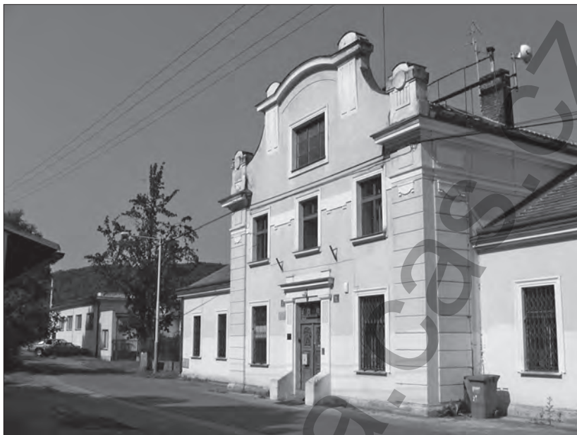
Budova Vodárny psychiatrické léčebny v Bohonicích, kde sídlil Archiv AV ČR od r. 1992 (A AV ČR, Povodně 2002, foto Milan Barvík, 26. 6. 2002)
