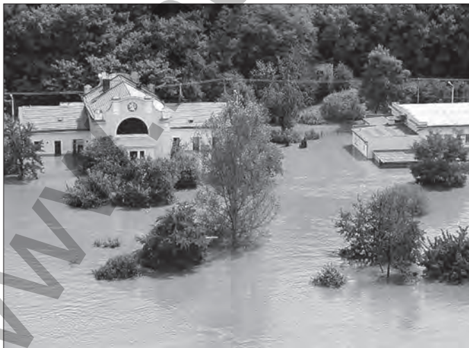
Detailní záběr zatopeného objektu Archivu AV ČR v Bohnicích (A AV ČR, Povodně 2002, foto Milan Barvík, 14. 8. 2002)
