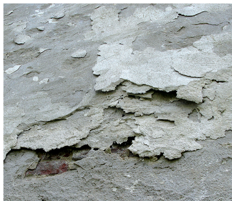
OBRÁZEK 63: Kombinované poškození lístkovatěním souvrství nátěrů (maleb) a štukových vrstev se ztrátou materiálu (vlevo) a lístkovatěním vyvolané mrazem (vpravo) (Foto M. Drdácký)
