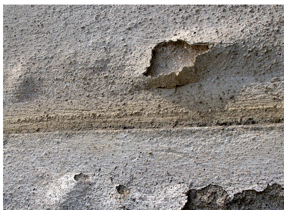
OBRÁZEK 61: Uzavřené a otevřené puchýře v povrchových vrstvách lokálně oddělených od podkladu (jádrové omítky) (Foto M. Drdáčký)
