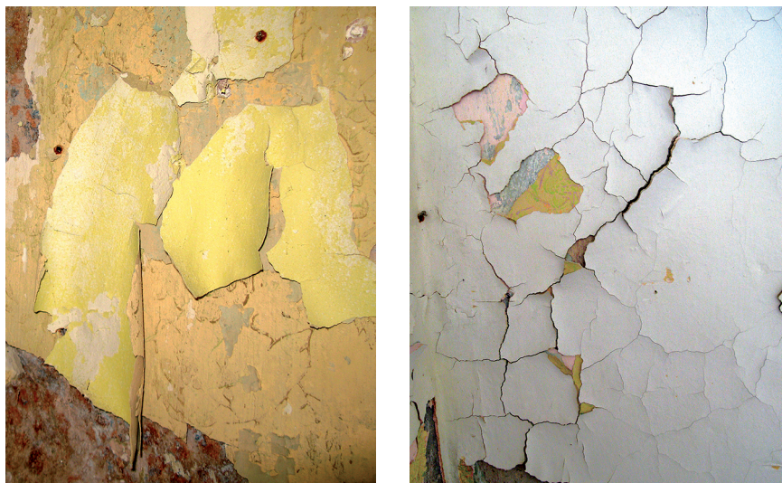
OBRÁZEK 66: Příklad odlupování tenkých vrstev (Foto M. Drdácý)
