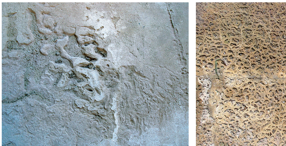
OBRÁZEK 69: Selektivní eroze (vlevo), alveolizace (vpravo) (Foto M. Drdácý)
