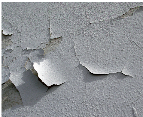
OBRÁZEK 62: Deformace rozpraskaných a oddělených částí povrchové vrstvy ve tvary konvexního ohybu odtržených lístků je klasifikována jako rozkvétání (Foto M. Drdácký)
