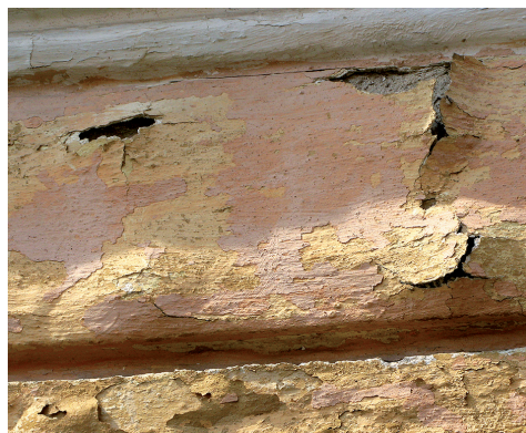
OBRÁZEK 62: Deformace rozpraskaných a oddělených částí povrchové vrstvy ve tvary konvexního ohybu odtržených lístků je klasifikována jako rozkvétání (Foto M. Drdácký)
