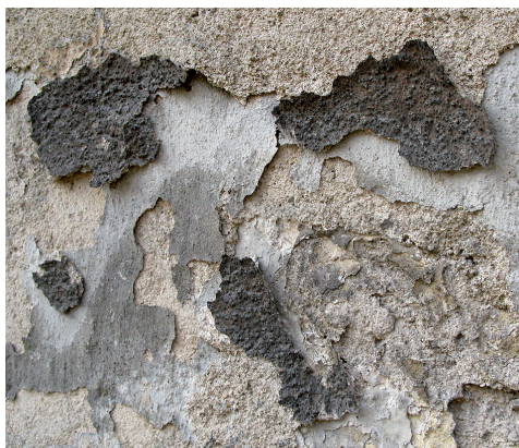
OBRÁZEK 63: Kombinované poškození lístkovatěním souvrství nátěrů (maleb) a štukových vrstev se ztrátou materiálu (vlevo) a lístkovatěním vyvolané mrazem (vpravo) (Foto M. Drdácký)
