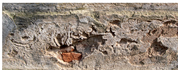
OBRÁZEK 70: Selektivní degradace a eroze (Foto M. Drdácý)
