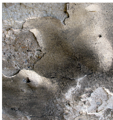
OBRÁZEK 61: Uzavřené a otevřené puchýře v povrchových vrstvách lokálně oddělených od podkladu (jádrové omítky) (Foto M. Drdáčký)
