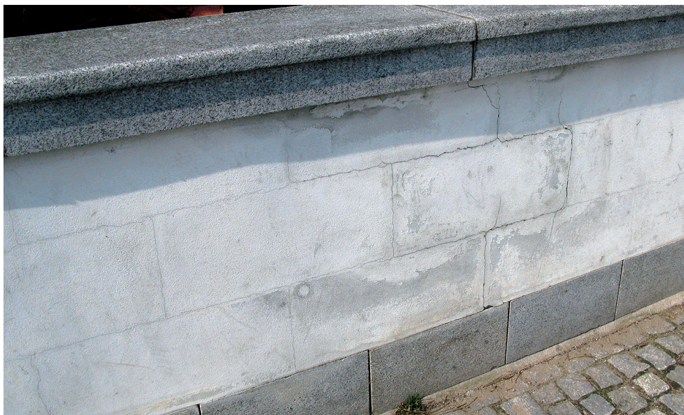
OBRÁZEK 55: Jemné trhliny jako výsledek dilatačních pohybů bloků zdiva teplotní roztažností. V takovém případě nelze vzniku trhlín zabránit a poruchy mohou být pouze zakryty vrstvou malty vyztuženou pletivem nebo jejich viditelnost snížena pravidelnými nátěry (Foto M. Drdácý)
