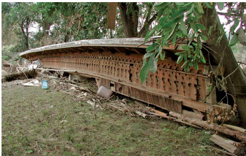
OBRÁZEK 115: Utržená a odplavená střecha kuželníku – Podhoří 2002 (Foto M. Drdáčký)
