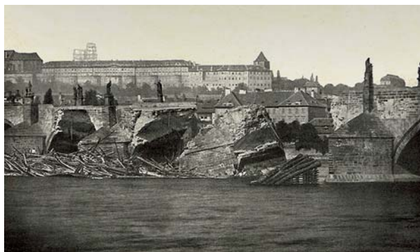
OBRÁZEK 119: Havárie Karlova mostu v Praze při povodni v roce 1890 (R. Bruner-Dvořák)
