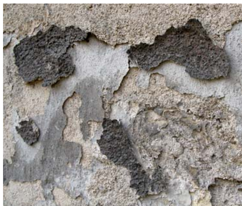
OBRÁZEK 63: Kombinované poškození lístkovatěním souvrství nátěrů (malby) a štukových vrstev se ztrátou materiálu (vlevo) a lístkovatění vyvolané mrazem (vpravo) (Foto M. Drdácký)
