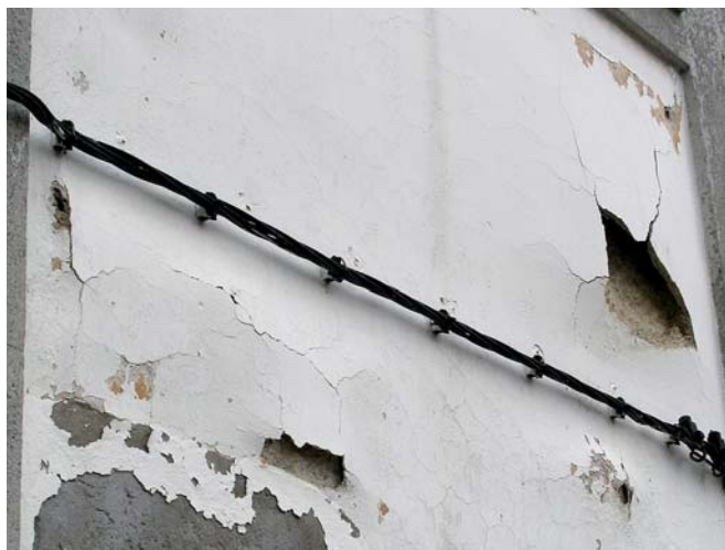
OBRÁZEK 60: Příklady boulení i s částečnou ztrátou materiálu (vpravo nahoře) (Foto M. Drdácý)
