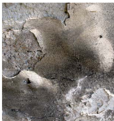
OBRÁZEK 61: Uzavřené a otevřené puchýře v povrchových vrstvách lokálně oddělených od podkladu (jádrové omítky) (Foto M. Drdácý)
