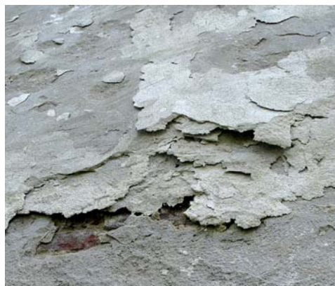
OBRÁZEK 63: Kombinované poškození lístkovatěním souvrství nátěrů (malby) a štukových vrstev se ztrátou materiálu (vlevo) a lístkovatění vyvolané mrazem (vpravo) (Foto M. Drdácký)
