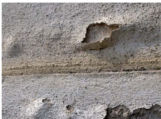
OBRÁZEK 61: Uzavřené a otevřené puchýře v povrchových vrstvách lokálně oddělených od podkladu (jádrové omítky) (Foto M. Drdácý)
