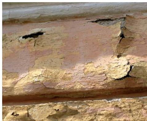
OBRÁZEK 62: Deformace rozpraskaných a oddělených částí povrchové vrstvy ve tvary konvexního ohybu odtržených lístků je klasifikována jako rozkvětání (Foto M. Drdácký)
