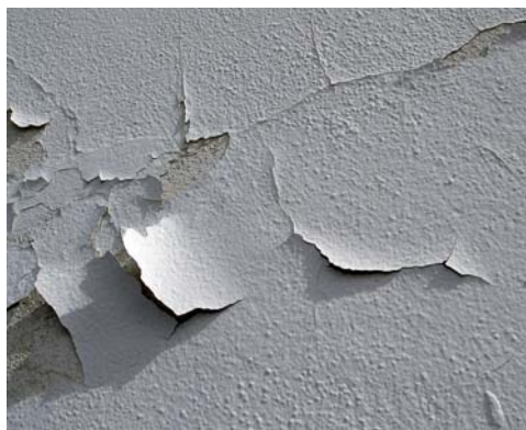
OBRÁZEK 62: Deformace rozpraskaných a oddělených částí povrchové vrstvy ve tvary konvexního ohybu odtržených lístků je klasifikována jako rozkvětání (Foto M. Drdácký)
