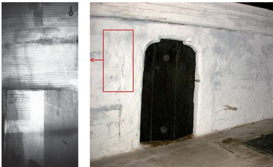
OBRAZEK 185: Rentgen styku sloupku a překlady dřevěné zárubně pod nátěry vápnem (Trstenice). Dobře je patrné zapuštění vodorovných dřev roubené stěny do sloupku zárubně (vlevo). Rentgenovaná zárubeň v Čisté (vpravo). Dřevo zárubně i roubenice je skryté pod vrstvami vápenných pačoků.
