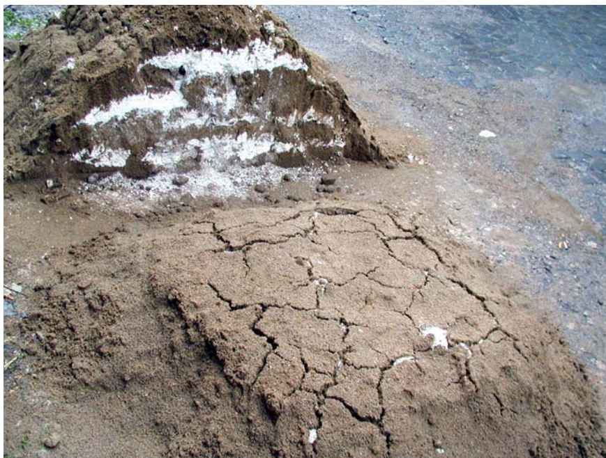
OBRÁZEK 136: Příprava horké malty, kdy vrstvy vápna s pískem jsou ponechány několik desítek dní ve venkovním prostředí. Vápno se postupně vyhasí (Foto M. Hřečka)
