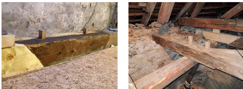
OBRÁZEK 148: Vlevo krov na zámku v Lanškrouně s aplikovaným dvouhmoždíkovým spojem, vpravo krov kostela v Červené Vodě
