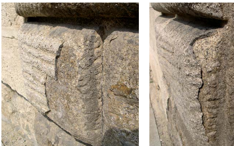
OBRAZEK 65: Oddělení a odpadnutí opravné vrstvy umělého kamene (Foto M. Drdácý)
