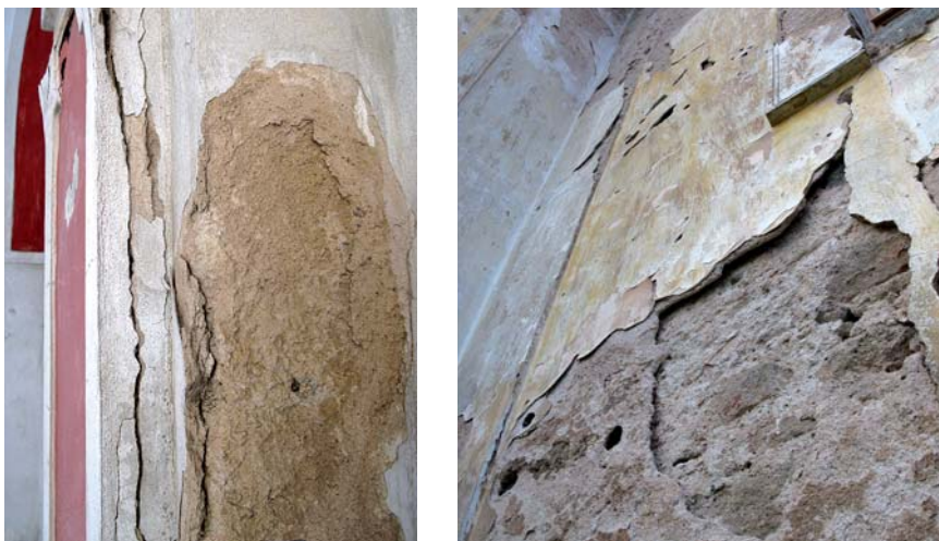
OBRAZEK 64: Oddělení velkých ker omítky v důsledku degradace jádrové omítky na rozhraní s podkladem nebo jejím rozpadem (Foto M. Drdácý)
