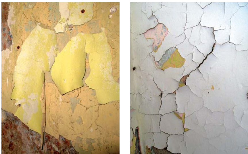
OBRÁZEK 66: Příklad odlupování tenkých vrstev (Foto M. Drdácěk)
