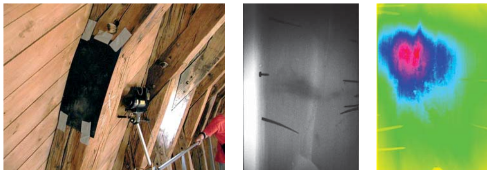
OBRAZEK 187: Uspořádání rentgenového měření v krovu kostela sv. Anny v Praze (vlevo) – na krokvi je snímač záření (černá deska), z druhé strany záříč. Snímky dále ukazují rentgenový záznam snímané krokve (uprostřed) a místa na jiné krokvi s nalezenou hnilobou (vpravo) po barevném zvýraznění intenzit procházejícího záření.
