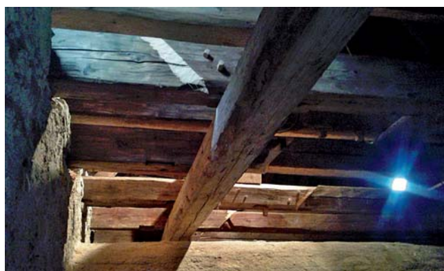
OBRÁZEK 149: Výsledek – aplikace vyvinutých spojů v krovu
