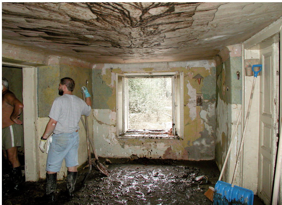
OBRAZEK 127: Příklad znečištění domu, který byl celý pod hladinou vody (Foto M. Drdácý)
