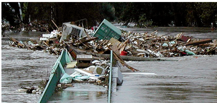
OBRÁZEK 121: Bariéra vytvořená na pěší lávce v Troji v roce 2002 (Foto T. Drdáčký)
