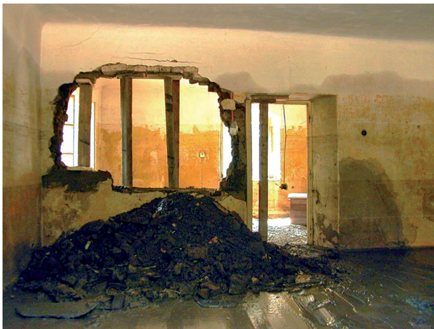
OBRAZEK 118: Vodním proudem probouraná hliněná zeď – Veltrusy 2002 (Foto M. Dropka)
