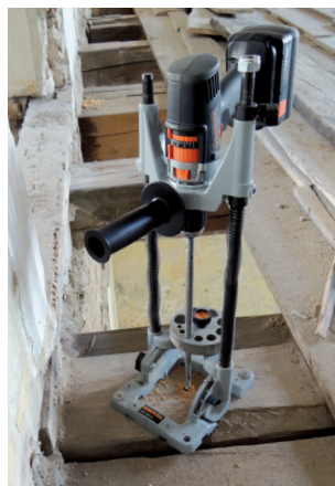
OBRÁZEK 12: Speciální stojánek pro upevnění vrtáčky s vrtákem a ukotvení k prvku
