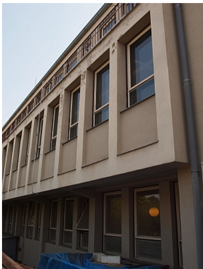
Stav severního průčelí.
