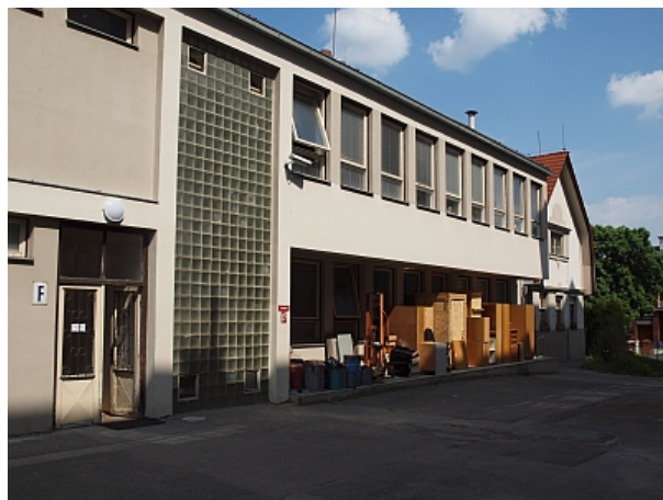
Jižní strana budovy s hlavním vstupem a budovou D.
