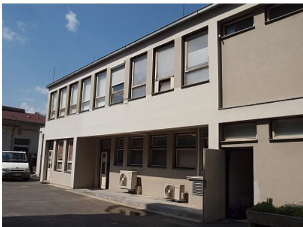
Celkový pohled na budovu F z jižní strany, ze dvora.
