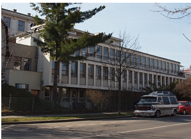
Celkový pohled na severní průčelí z ulice Na Ořechovce.
