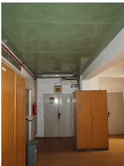
Chodba u vstupu v 1.NP
