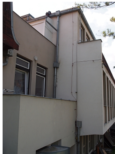
Terasa v 1.NP na severní straně spojovacího krčku.
