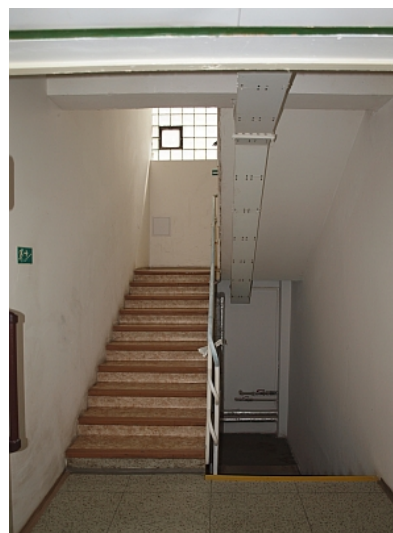
Stav schodiště v 1.PP.
