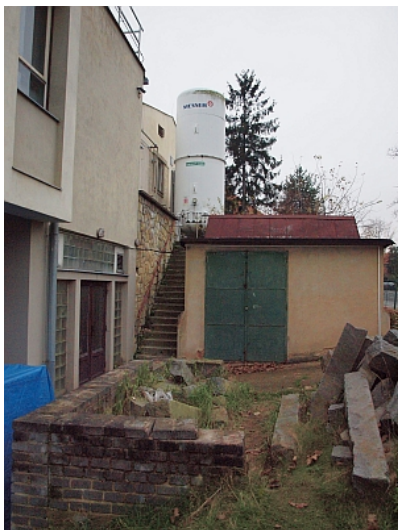
Příjezd na severní straně budovy.
