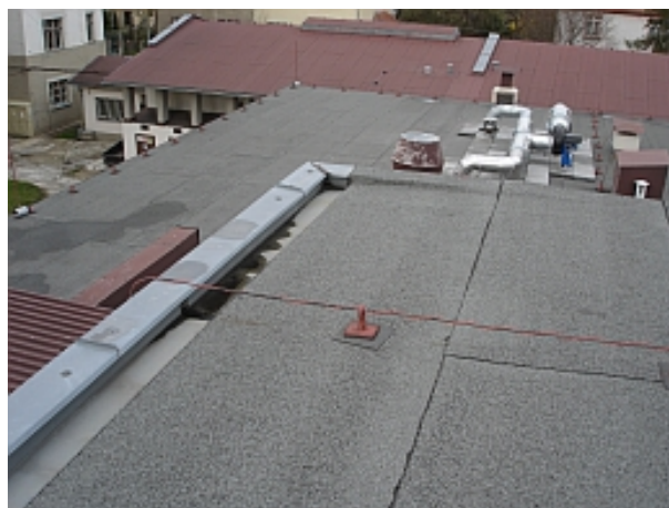
Střeška nástaveb se zaatíkovým žlabem.
