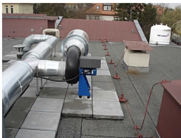
Stav střešky s prostupy instalačních jader a vzt. zařízení.
