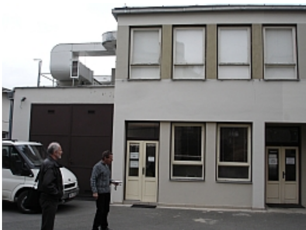
Okna v 2. NP jižního průčelí.
