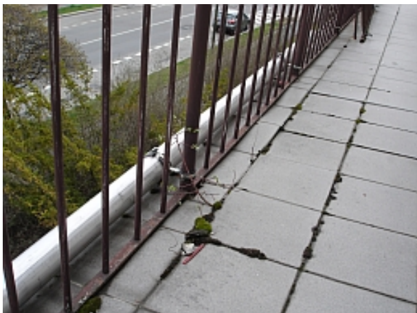
Stav terasy v 2.NP na severní straně budovy.
