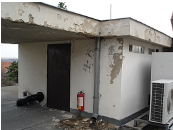
Střešní nástavba strojovny vzt.
