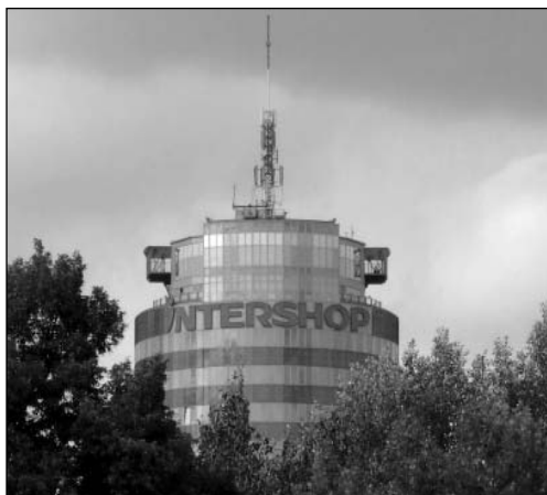
Podle výrazného nápisu na fasádě dostala pojmenování nejvyšší kancelářská budova bývalé NDR. Intershop Tower v Jeně byl postaven v letech 1970–1972 (foto Seebaer, www.panoramio.com )
