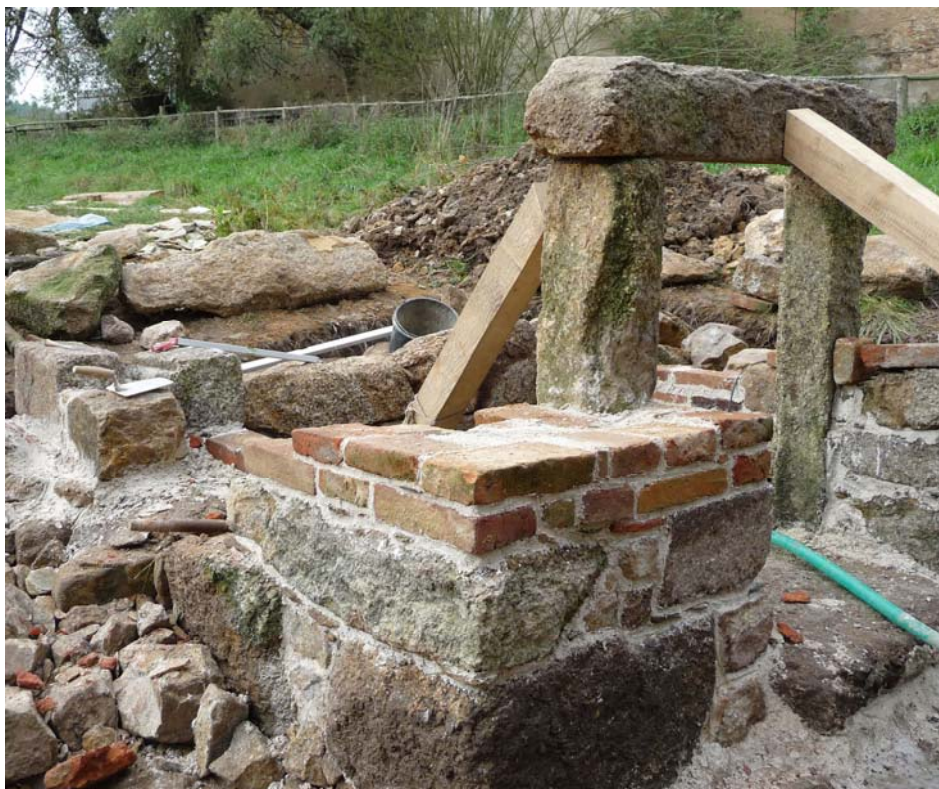
Rekonstrukce haltýře v obci Salajna, Česká republika
