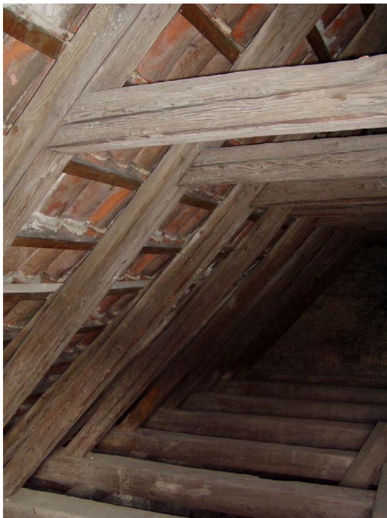
Krovová konstrukce barokního kostela
