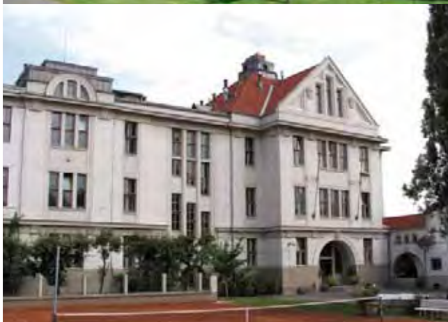
FZÚ AV ČR – pracoviště Cukrovarnická 10 v Praze 6
