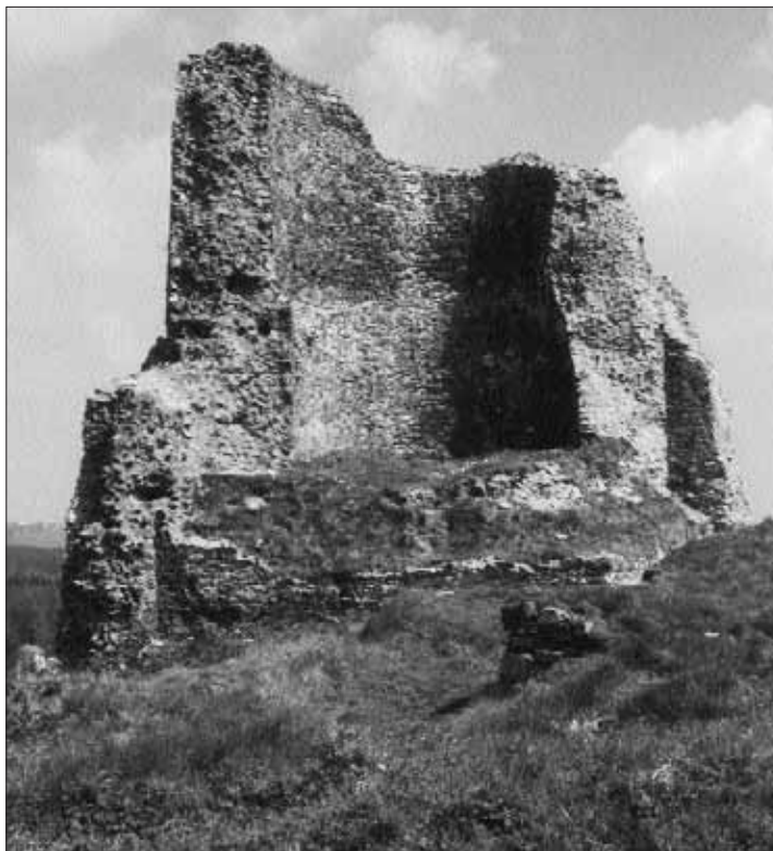
Obr. 23. Lichnice, hrad. Věž v severovýchodním nároží, pohled od západu. Foto V. Razím 2003. — Abb. 23. Lichnice, Burg. Turm an der Nordostecke, Blick von Westen. Foto V. Razím 2003.
