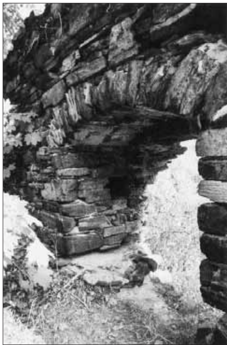
Obr. 12. Rýzmburk, hrad. Detailní pohled do niky střílny pro palnou zbraň v jižní části vnější hradby, s otvorem pro zasouvací břevno. Srov. obr. 9: 4; 10; 11: A. Foto V. Razím 2003. — Abb. 12. Rýzmburk, Burg. Detailblick in die Nische einer Schiesscharte für Feuerwaffe im Südteil der äußeren Wehrmauer, mit einer Öffnung für die Schubriegel. Vgl. Abb. 9: 4; 10; 11: A. Foto V. Razím 2003.
