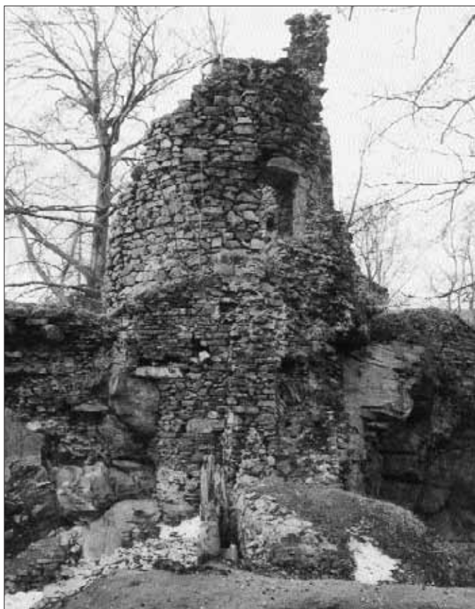
Obr. 18. Rýzmburk, hrad. Válcová věž u brány do jádra hrad, pohled od východu. Nad druhotnou obehzdívkou spodní části věže původní vchod. Foto V. Razím 2003. — Abb. 18. Rýzmburk, Burg. Rundturm beim Tor in die Kernburg, Blick von Osten. Über der sekundären Ummauerung des Unterteiles des Turmes der ursprüngliche Eingang. Foto V. Razím 2003.
