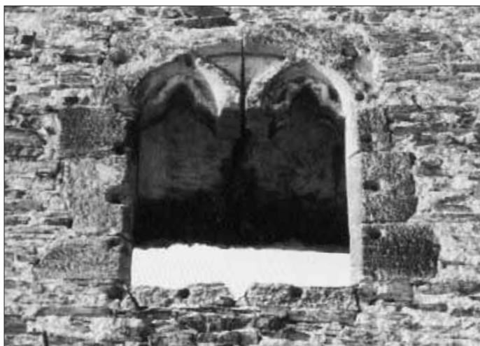
Obr. 4. Říčany, hrad. Detail jednoho z dochovaných sdrúžených oken v 1. patře raně gotického paláce. Foto V. Razím 2003. — Abb. 4. Říčany, Burg. Detail eines der erhaltenen Kuppelfenster im 1. Stock des frühgotischen Palastes. Foto V. Razím 2003.
