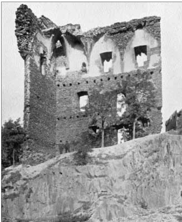
Obr. 3. Říčany, hrad. Zřícenina raně gotického paláce se zbytky žebrově klenuté síně ve 2. patře (převzato z Trnka 1913 ). – Abb. 3. Říčany, Burg. Die Ruine des frühgotischen Palasts mit den Resten eines ripengewölbten Saales im 2. Stockwerk (übernommen von Trnka 1913 ).
