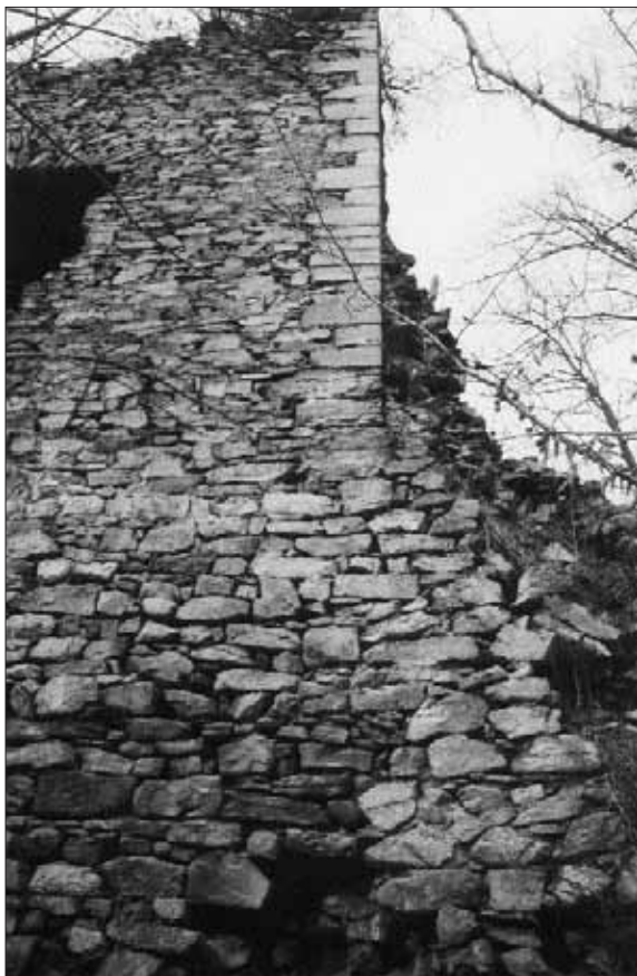
Obr. 14. Rýzmburk, hrad. Detail jižního průčelí jihozápadní nárožní věže jádra hradu, druhotně připojeného k jižní zdi pozdější kaple (dole). Foto V. Razím 2003. — Abb. 14. Rýzmburk, Burg. Detail der Südfront des südwestlichen Eckturmes der Kernburg, die sekundär an die Südmauer der späteren Kapelle angefügt wurde (unten). Foto V. Razím 2003.
