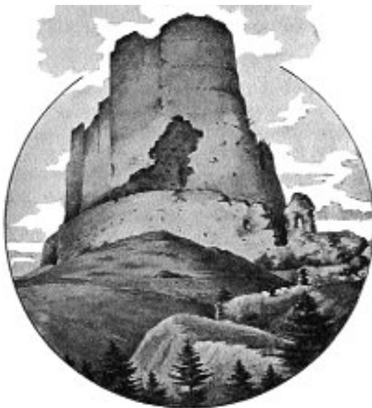
Obr. 24. Lichnice, hrad. Věž v severovýchodním nároží, pohled od severovýchodu. Stav tři desítky let před započatím rekonstrukce hradu. Na věži je dobře patrná svislá spára, související s výstavbou pláště ve dvou fázích. Pravá (severní) část naobrazení je nejspíše mladší (převzato z Klaus 1898 ). — Abb. 24. Lichnice, Burg. Turm an der Nordostecke, Blick von Nordosten. Zustand drei Jahrzehnte vor dem Beginn der Rekonstruktion der Burg. Am Turm ist gut sichtbar eine senkrechte Fuge, die mit der Erbauung des Mauermantels in zwei Phasen zusammenhängt. Der rechte (nördliche) Teil auf der Abbildung ist am ehesten jünger (übernommen aus Klaus 1898 ).
