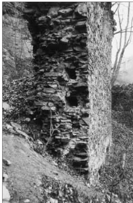
Obr. 20. Rýzmburk, hrad. Zbytky brány v hradební zdi pod východní stranou obytné věže jádra hradu (obr. 9: 15). Dvě kapsy pro zasouvací závozy za zaniklým ostěním, vlevo od nich fragment líce špalety. Foto V. Razím 2003. — Abb. 20. Rýzmburk, Burg. Reste des Tores in der Wehrmauer unterhalb der Ostseite des Wohnturmes der Kernburg (Abb. 9: 15). Zwei Riegellöcher für Schubriegel hinter dem untergegangenen Gewände, links das Fragment einer Leibungsfläche. Foto V. Razím 2003.
