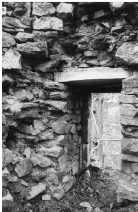
Obr. 19. Rýzmburk, hrad. Detail interiéru věže u brány do jádra hradu. Nika vchodu (srov. obr. 18) je zastropena původními dubovými trámy (dendrochronologické datum 1248/1249). Foto V. Razím 2003. — Abb. 19. Rýzmburk, Burg. Detail des Interieurs des Turmes bei dem Tor in die Kernburg. Die Eingangsnische (vgl. Abb. 18) ist mit den ursprünglichen Eichenramen überdacht (dendrochronologisches Datum 1248/1249). Foto V. Razím 2003.
