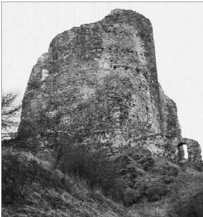
Obr. 25. Lichnice, hrad. Věž v severovýchodním nároží, pohled od severovýchodu. Vpravo část pláště s původními otvory po dřevěch lešení a výztuh zdiva (srov. obr. 24). Foto V. Razím 2004. — Abb. 25. Lichnice, Burg. Turm an der Nordostecke, Blick von Nordosten. Rechts ein Teil des Mauermantels mit den ursprünglichen Rüstlöchern (vgl. Abb. 24). Foto V. Razím 2004.
