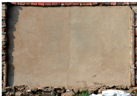
OBRÁZEK 138: Čerstvě nahozená horká malta jako zkušební omítkový panel na hřbitovní zdi v Krchlebech u Čáslavi
