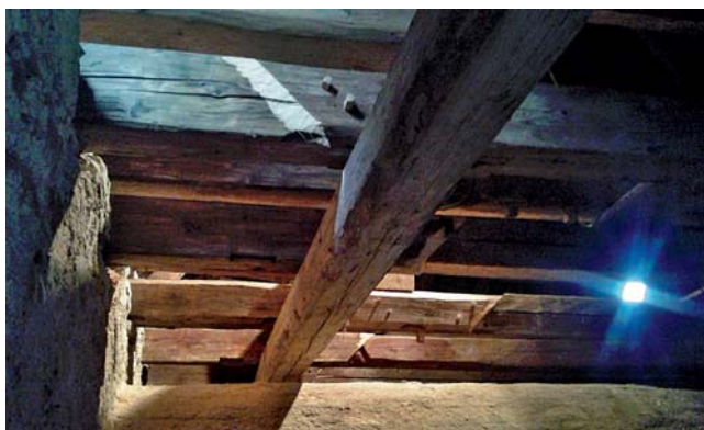
OBRÁZEK 149: Výsledek – aplikace vyvinutých spojů v krovu
