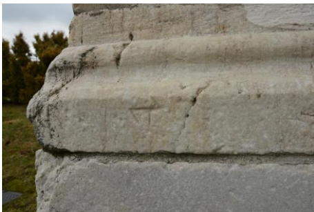
10 Kamenická značka, soklové obložení jihovýchodního opěráku, kostel sv. Prokopa, Žďár nad Sázavou.
