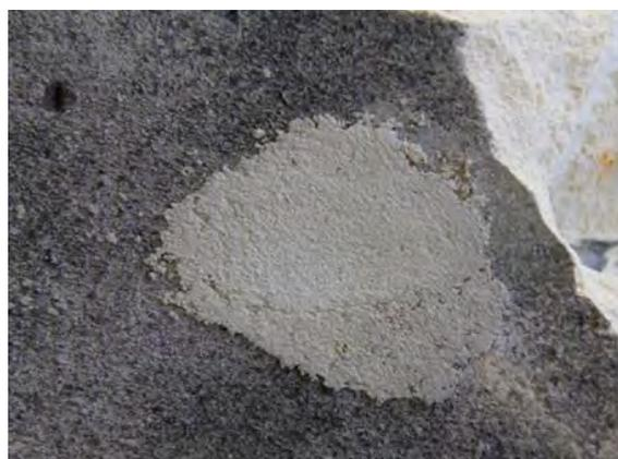
↑ Cementový doplněk (vytvořený v průběhu zajišťovacích opatření)
