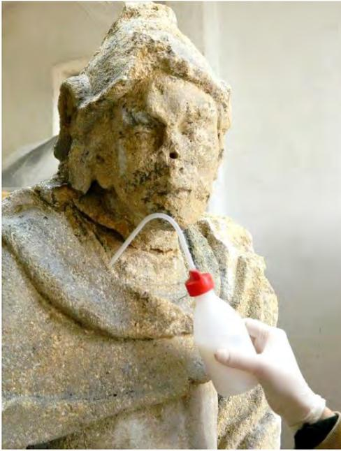
↑ Konsolidace - aplikace prostředku CaLoSiL® E25 pomalým napouštěním pomocí laboratorní stříčky
