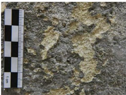
↑ Povrch vápence pokrytý kompaktní krustou (makrofoto), která se místy odděluje od podkladu. Vápenec je pod krustou na mnoha místech nesoudržný, dochází k jeho dezintegraci tzv. pískovatěním.
