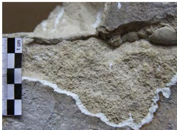
↑ Injektáž okraje praskliny na fragmentu BU2, pomocí CaLoSil®Injection grout
