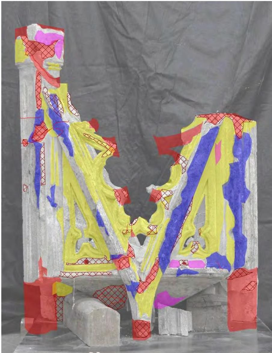
← Grafické znázornění (mapování) hlavních projevů poškození baldachýnu
