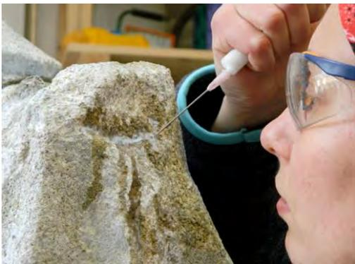
↑ Injektáže prasklin pomocí injekční stříkačky s jehlou bezprostředně po konsolidaci
