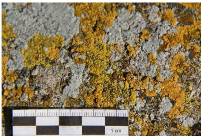
← Makrofotografie, detail struktury povrchu horniny s biologickou kolonizací (řasy a lišejníky)
