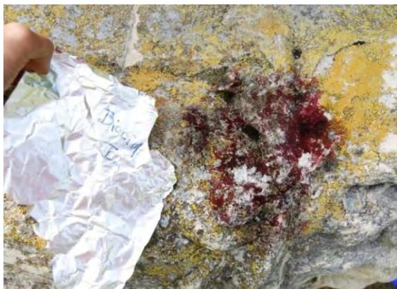
↑ Vzhled biogenních povlaků těsně po ukončení aplikace vápenné nanosuspenze
