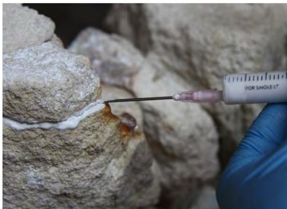
↑ Injektáž prasklin na fragmentu BU2, pomocí CaLoSil®Injection grout.
