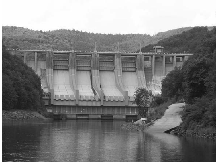
Abb. 6: Damm der Talsperre Slapy an der Moldau, deren Errichtung die Ausgrabungen auf dem Oppidum Hrazany zur Folge hatte (Foto: V. Salač).
