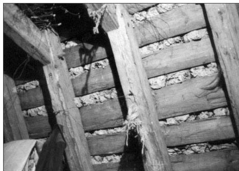
Obr. 15. Krnín čp. 3. Lepenec v horní komoře západní části kamenného špýcharového domu (foto Ernée 1996). — Abb. 15. Krnín Haus–Nr. 3. Dachstuhl mit äußeren Lehbewurt in der oberen Kammer des Westteils des Wohnspeicherhauses (Foto Ernée 1996).
