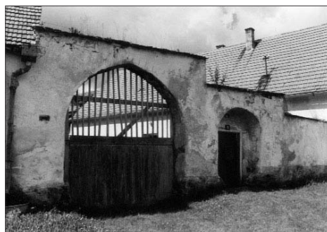
Obr. 4. Čertyně čp.10. Vstupní brána do usedlosti s lomeným obloukem vjezdu, pozdní středověk, pohled od severu (foto Ernée 1996). — Abb. 4. Čertyně, Haus-Nr. 10. Tor zum Bauernhof mit Spitzbogen, Spätmittelalter, Blick von Norden (Foto Ernée 1996).
