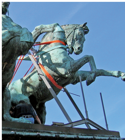
OBRÁZEK 262: Podpůrný rám a zavěšení sochy koně pomocí popruhů pro zatížení nadlehčováním (Foto Sh. Urushadze)
