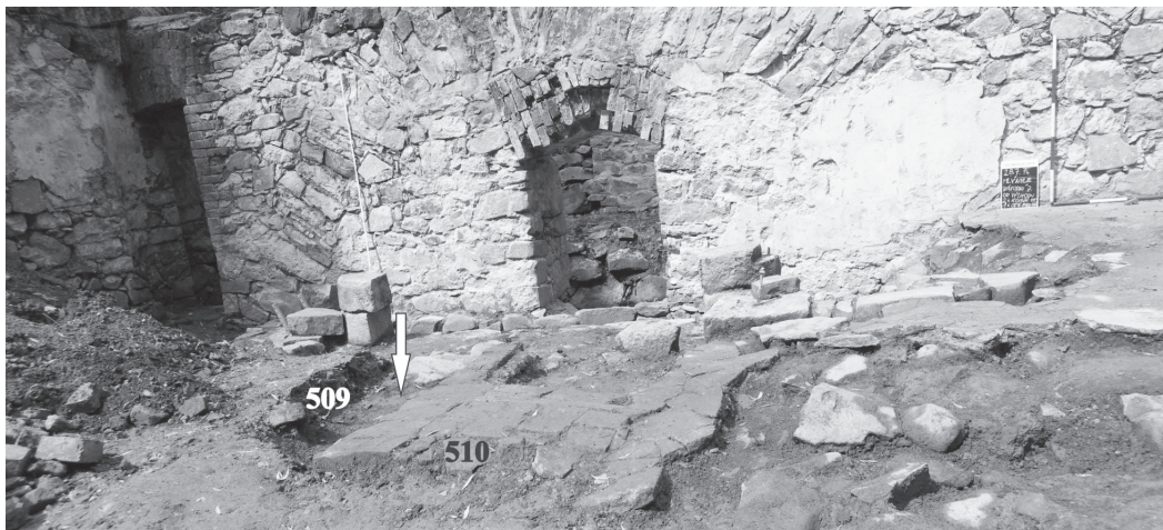
Obr. 5. Touchořiny čp. 40. Sonda 5 – poloha hlinitých vrstev (509, 511 a 512). Vrstva 509 označena bílou šipkou. Na snímku je dále patrná stratigrafická jednotka 510 (cihlová konstrukce či zbytek dlaby). Pohled od východu (foto L. Galusová 2014).
