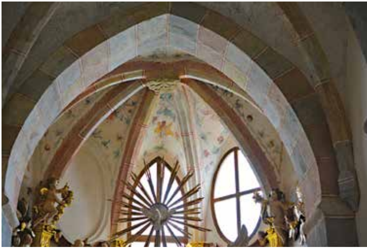
2 Pohled do presbytáře jižní chórové kaple. Cisterciácký klášter, Žďár n. Sázavou.
