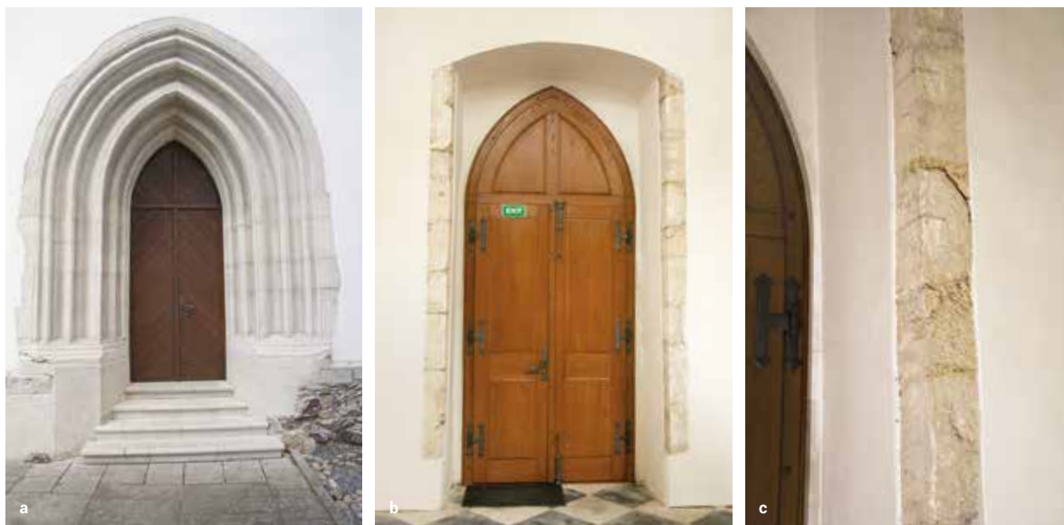
4 Jižní portál vstupu do kostela z klášterních prostor (a). Pohled na nároží vstupního otvoru z interiéru kostela (b) a relikty povrchových úprav včetně malovaného kvádrování (c).
