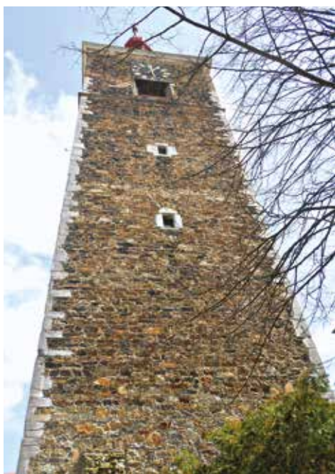
33 Přibyslav, věž u kostela Narození svatého Jana Křtitele – mramorové stavební prvky v ostění oken a rohových kamenů.
