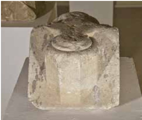
39 Okenní lavice s patkami prutů okenní kružby. Muzeum nové generace. Cisterciácký klášter, Žďár n. Sázavou.
