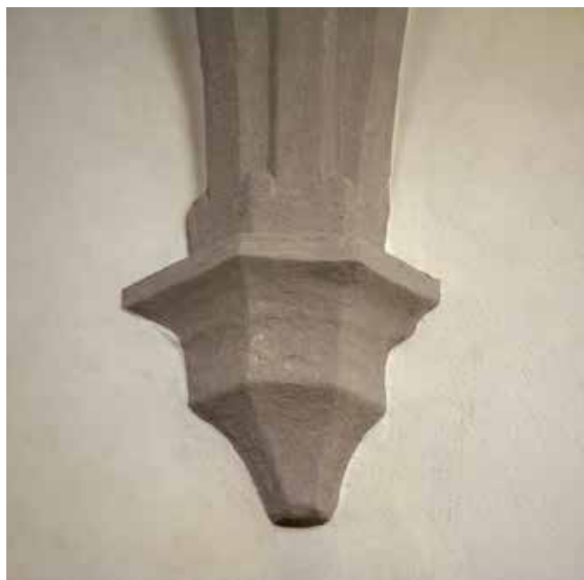
19 Detail klenební konzoly v jižní boční lodi. Cisterciácký klášter, Žďár n. Sázavou.
