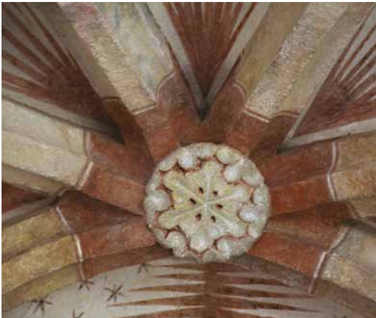
16 Svorník v severní kapli. Cisterciácký klášter, Žďár n. Sázavou. Foto J. Válek 2017.
