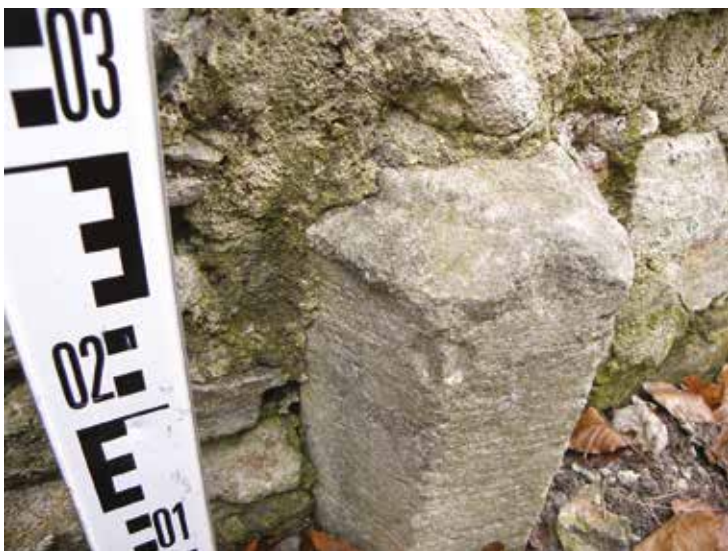
43 Fragment soklíku prutu ostění. Prvek je zazděn v prostoru jižního křídla bývalé kvadratury. Cisterciácký klášter, Žďár n. Sázavou.
