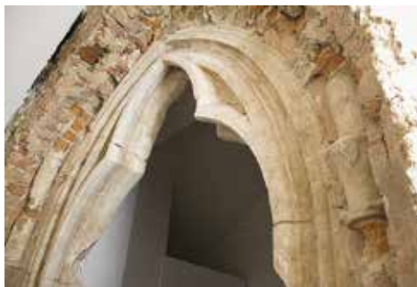
8 Portál vstupu do jídelny konvršů v západním křídle konventu.
