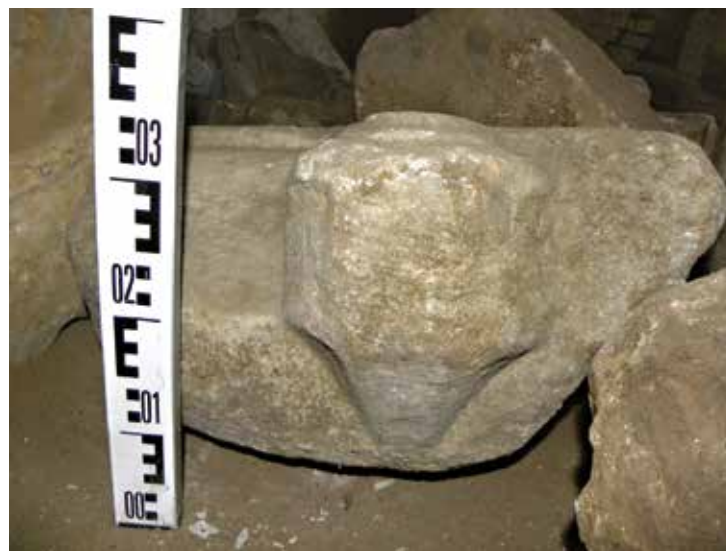
44 Vnější strana okenního parapetu s patkami prutů okenní kružby. Lapidárium. Cisterciácký klášter, Žďár n. Sázavou.
