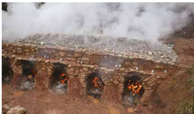
20 Experimentální výpal ve středověké vápenné peci ze 13.–14. století. Mokrá u Brna.
