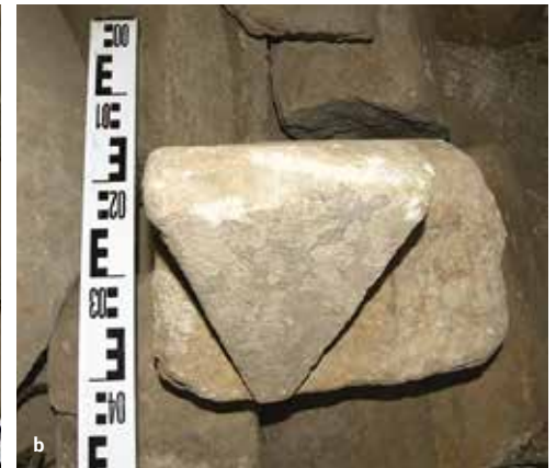
42 Konzolovitě vnesená patka ostění, která byla přetesána v konzolu jehlancového tvaru. Lapidárium. Cisterciácký klášter, Žďár n. Sázavou.
