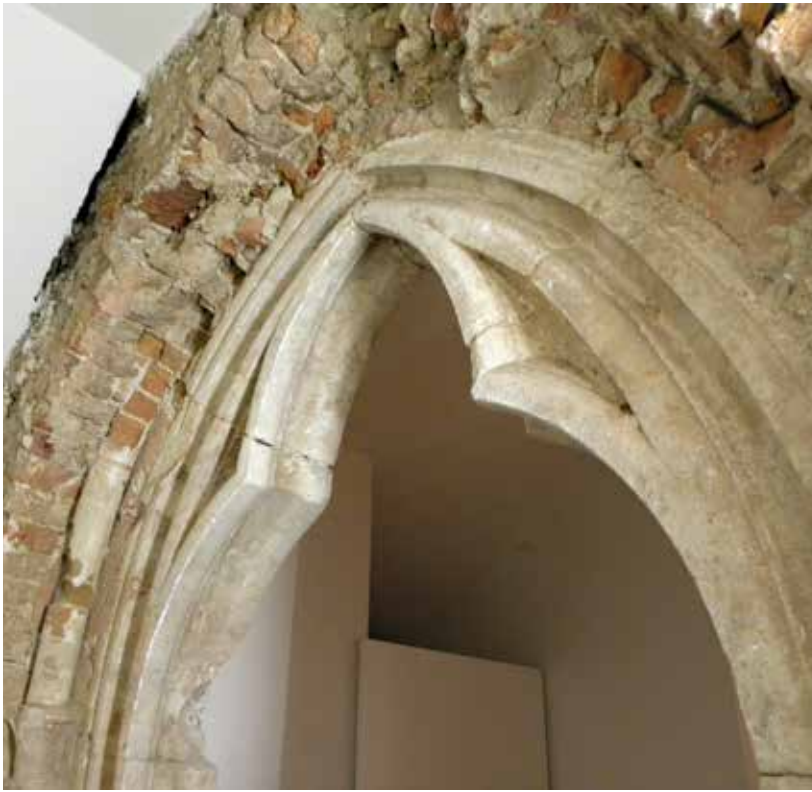
26 Portál v přízemí západního křídla konventu. Cisterciácký klášter, Žďár n. Sázavou.
