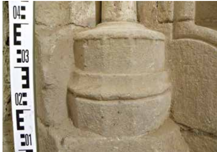
35 Detail patky západního portálu v přízemí západního křídla konventu. Cisterciácký klášter, Žďár n. Sázavou.
