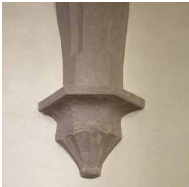
20 Detail kanelované konzoly v jižní boční lodi. Cisterciácký klášter, Žďár n. Sázavou.
