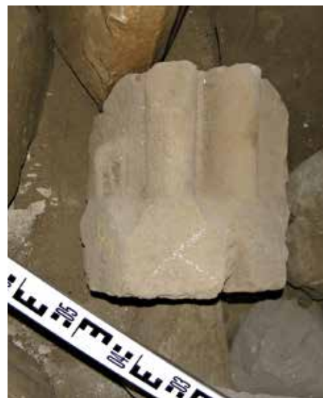
31 Výběh vejčitých žeber ze srdčitých náběžních štítků. Lapidárium. Cisterciácký klášter, Žďár n. Sázavou.
