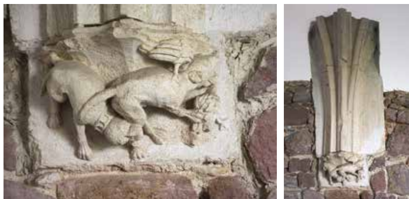
5 Konzola pod příporou svazku klenebních žeber v ambitu kláštera cisterciáček (nyní augustiniánů) „Aula Sanctae Mariae“ v Brně. Konzola, přípora i pruty žeber jsou z brněnského krinoidového vápence z 1. poloviny 14. století.
