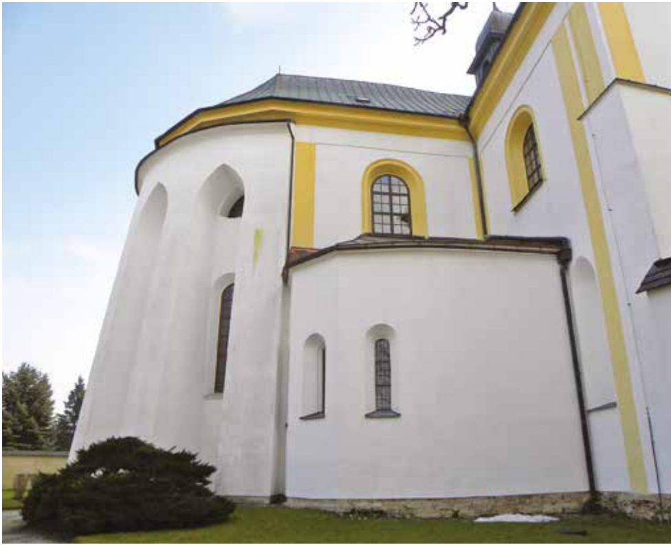
6 Pohled na závěr konventního kostela. Cisterciácký klášter, Žďár n. Sázavou.
