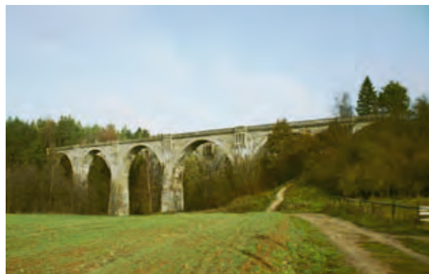
Ryc. 17. Mosty kolejowe w Stańczykach przy linii Kolejowej Gołdap (Goldap) – Żytkiejmy (Schittkehmen, Wehrkirchen) z lat 1923-1927 (fot. A. Żywiczyński)
