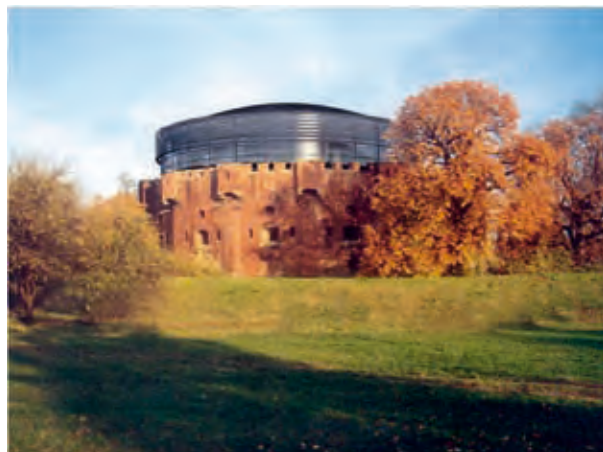
Ryc. 2. Fort nr 31, tzw. św. Benedykt, proj. Feliks Księżarski 1853-56. Wizualizacja projektowanej nadbudowy fortu (za: Gazeta Wyborcza, Forty Twierdzy Kraków – galeria zdjęć, 19 marca 2004 roku)
