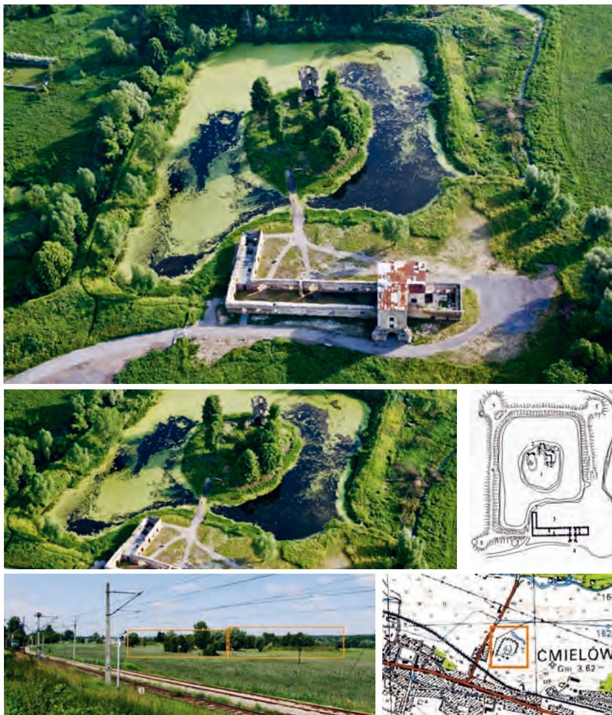
Ryc. 1. Zamek w Ćmielowie usytuowany na terenie zalewowym rzeki Kamiennej. Pomędzy zamkiem a miastem funkcjonuje linia kolejowa. Na ujęciach z lotu ptaka udokumentowano: ruiny zamku na wyspie oblanej wodami wewnętrznej fosy; mury obwodowe budynku Przedzamcza z korpusem bramnym (pod dachem), z pocz. XVI wieku. Fosę otaczają wały ziemnej fortyfikacji bastionowej z trzema zachowanymi bastionami. Zewnętrzna fosa jest zasypana (plan zamku – zbiory ZAP WA PW; fragment mapy – www.geoportal.gov.pl ; ujęcia z motolotni – zbiory właściciela zamku, 2010; fot. M.L. Lewicka, 2011)
