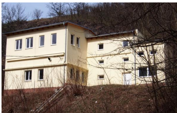
Obr. 3. Nová budova Laboratoře nanomateriálů.
