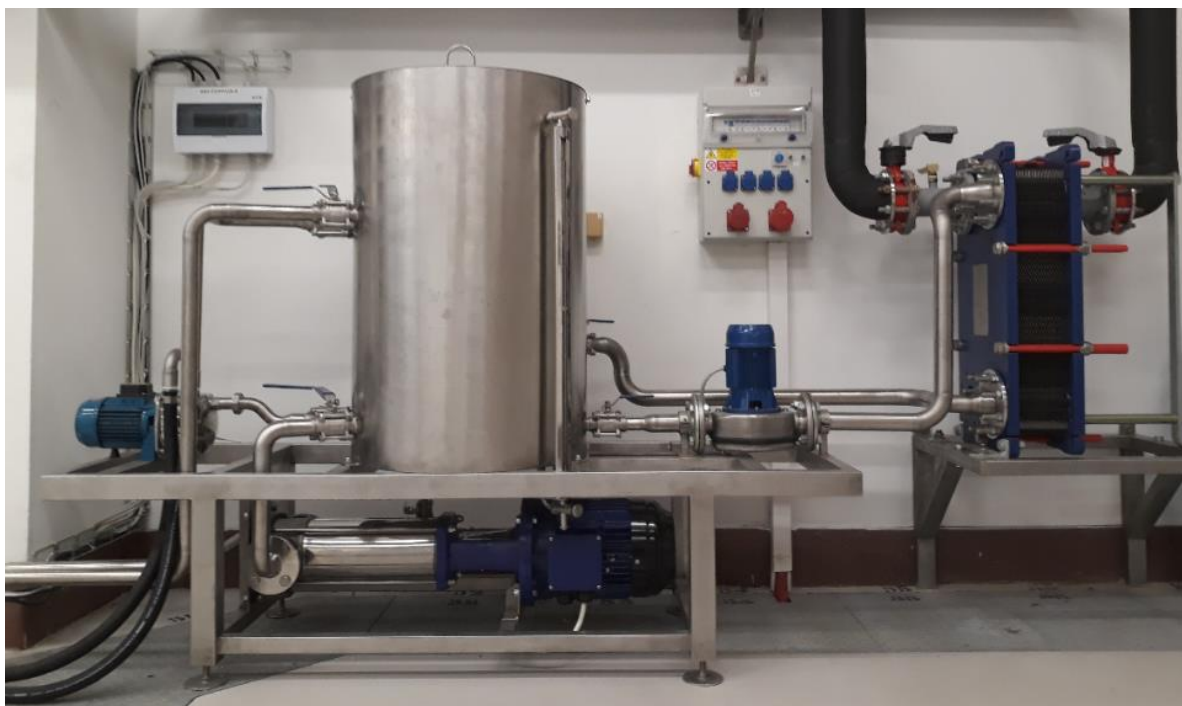
Terčové chladicí vodní okruhy cyklotronu TR-24.
