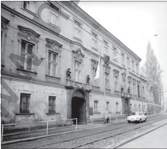
Budova ÚJČ v Letenské ulici 4, Praha 1 (A AV ČR)
