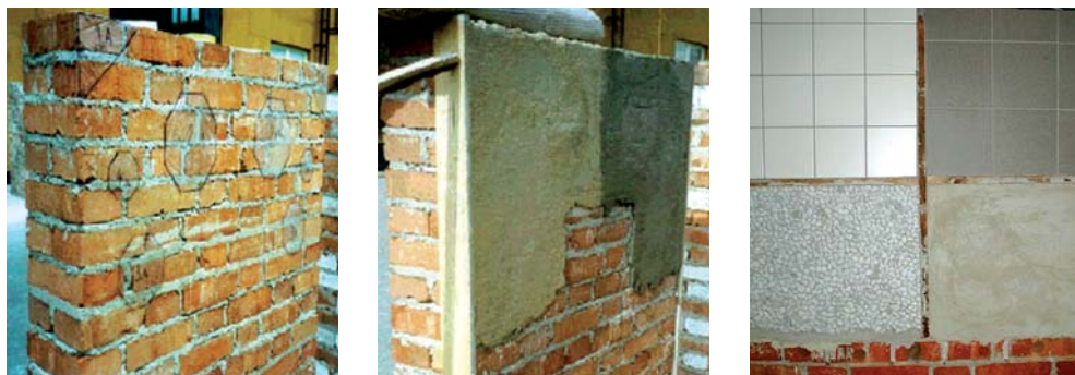
OBRÁZEK 176: Příprava modelové zdi se separačními fóliemi, které zabráňovaly kontaktu omítky se zdivem a tak modelovaly odtržení omítky nebo obkladu od povrchu (vlevo), zeď při omítání (střed) a kombinace omítky s obklady a mozaikou
