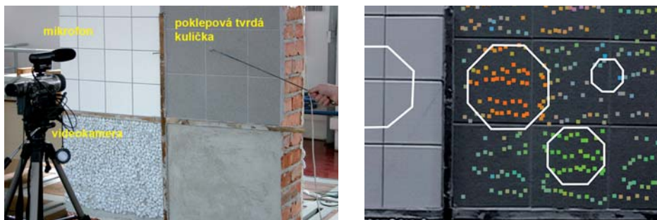
OBRAZEK 192: Uspořádání měření při poloautomatickém akustickém trasování (vlevo) a výsledek hledání pod povrchových defektů (plochy se světlými body vpravo)
