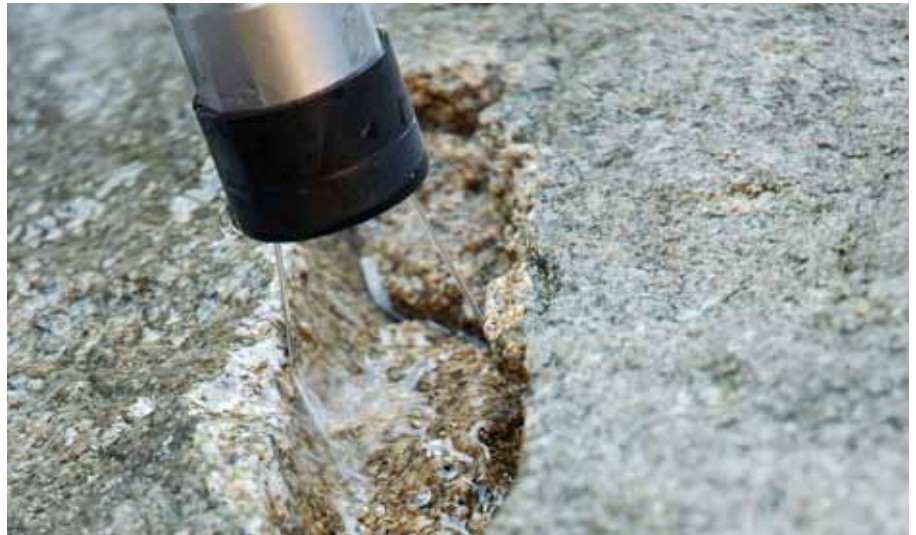
Drážka vytvořená rotačním pulzujícím vysokorychlostním vodním paprskem v žulovém masivu (lom Erlich, Žulová)
