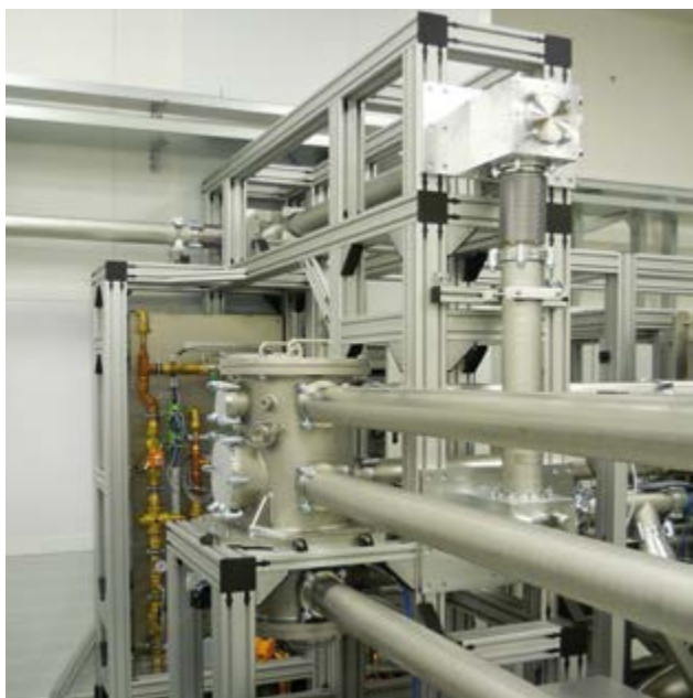
■ Obr. 20 Rámové konstrukce v L1 – most transportu seedového svazku.
