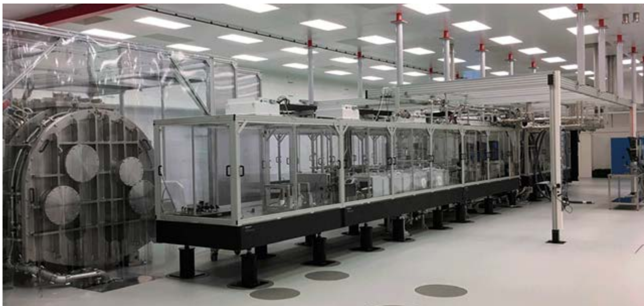
■ Obr. 6 Laserový systém L3-HAPLS instalovaný v centru ELI-Beamlines. Kompaktní laserový řetězec je umístěn na sedmi optických stolech, viditelných uprostřed a v pravé části obrázku. Závěsný rám nad laserovým systémem slouží k rozvodu chladicího média, vakua a elektrické kabeláže. Vakuový kompresor výstupních PW pulsů, viditelný v levé části obrázku, je v nynější fázi umístěn v odděleném prostoru zajišťujícím ultračisté prostředí pro instalaci difrakčních mřížek a dalších optických jednotek.
