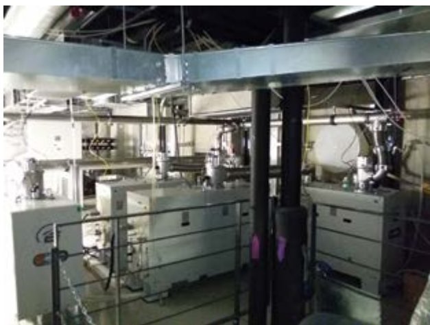
■ Obr. 25 Primární vývěvy Edwards GXS ve strojně.
