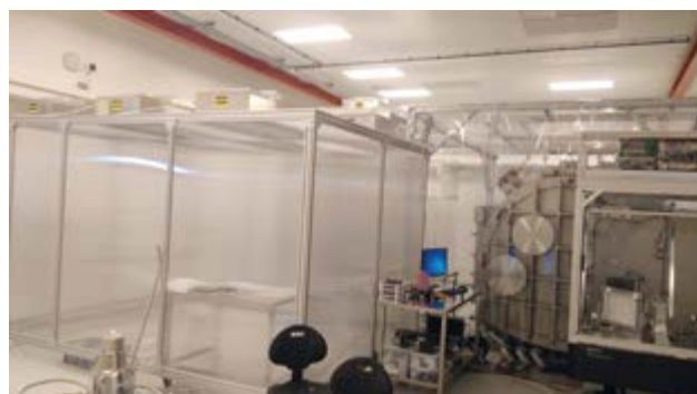
■ Obr. 23 Čistý stan pro kompresor L3 a instalaci optiky v L3.
