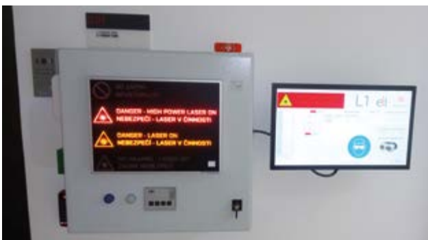
■ Obr. 28 LSS pro L1 oscilátorovnu (severní chodba).
