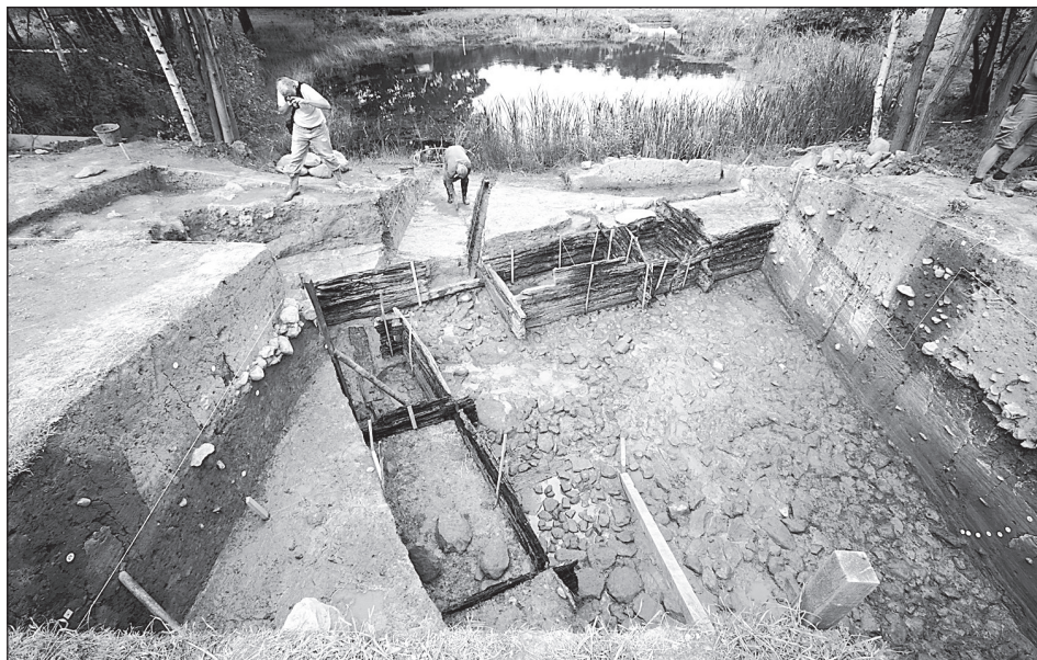
Abb. 23. Záhořice, Kr. Karlovy Vary. Die Grabung im Jahr 2010 erfasste östlich des Teiches eine ungestörte große Zisterne mit nahezu quadratischem Grundriss, die von einem mehr als ein Meter breiten Deich in Blockbauweise aus Eichenbalken umgeben war (Photo M. Frouz)
