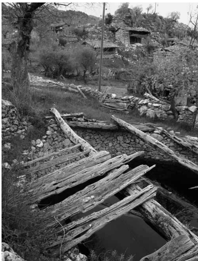
Obr. 27. Ovalná cisterna s kamenným obložení v osadě Beydilli v turecké Anatólii. Cisterna zachycuje vodu z pramene a zároveň vodu dešťovou. Má hloubku 2,5 metrů (od hladiny). Donedávna sloužila jako zdroj pitné vody pro obyvatele vesnice a pro dobytek. Původně byla zakryta štípanými fošnami – až na malý otvor, kterým se voda vybírala (foto P. Pokorný). — Fig. 27. Oval cistern with stone tiles at the Beydilli settlement in the Anatolia region of Turkey. With a depth of 2.5 m from the surface, the cistern traps water from the spring and also collects rainwater. Up until recently it was still used as a source of drinking water for villagers and cattle. The cistern was originally covered with hewn boards; water was drawn through a small opening (photo by P. Pokorný).
