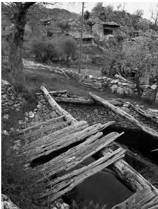
Obr. 27. Oválná cisterna s kamenným obložení v osadě Beydilli v turecké Anatólii. Cisterna zachycuje vodu z pramene a zároveň vodu dešťovou. Má hloubku 2,5 metrů (od hladiny). Donedávna sloužila jako zdroj pitné vody pro obyvatele vesnice a pro dobytek. Původně byla zakryta štípanými fošnami – až na malý otvor, kterým se voda vybírala (foto P. Pokorný). — Fig. 27. Oval cistern with stone tiles at the Beydilli settlement in the Anatolia region of Turkey. With a depth of 2.5 m from the surface, the cistern traps water from the spring and also collects rainwater. Up until recently it was still used as a source of drinking water for villagers and cattle. The cistern was originally covered with hewn boards; water was drawn through a small opening (photo by P. Pokorný).
