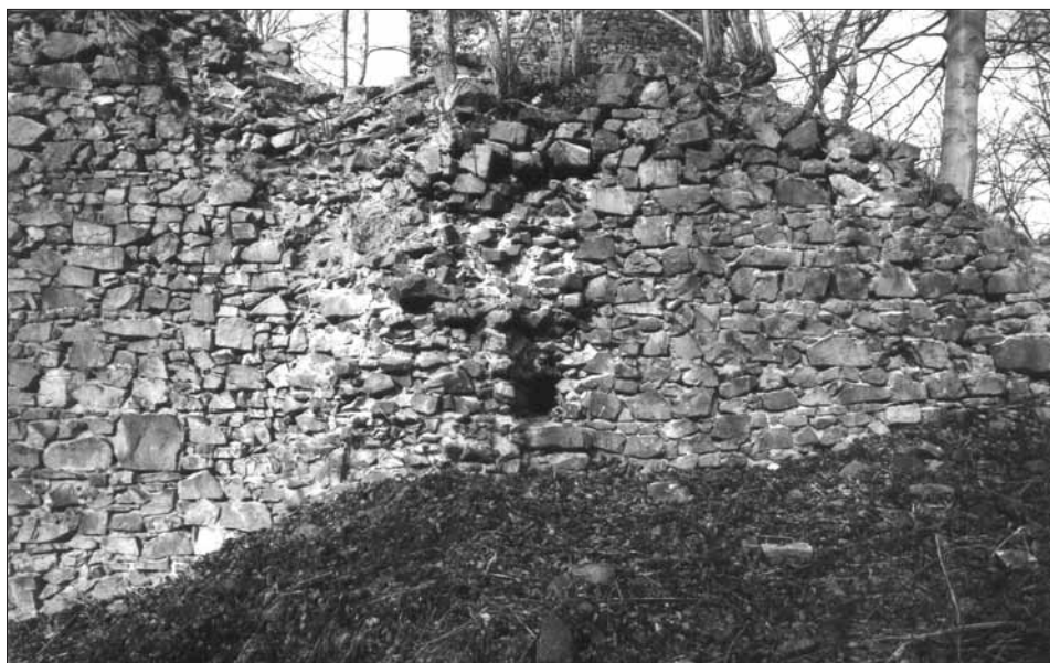
Obr. 11. Týřov, hrad. Pohled na vnější líc jižní části hradební zdi horního hradu. Uprostřed relikv hranolového pilíře s kapsou závory brány, vlevo od pilíře svislý technologický a petrografický předěl v líci zdiva (srov. obr. 10). V pozadí hlavní válcová věž. Foto V. Razím, 2002. — Abb. 11. Burg Týřov. Südlicher Ringmauerteil der oberen Burg, äußere Mauerflucht. In der Mitte Relikt des quadratischen Pfeilers mit der Torbalkenriegelscheide, links vom Pfeiler eine vertikale, in der Mauerflucht deutliche technologische und petrographische Trennung (vergl. Abb. 10). Im Hintergrund der runde Hauptturm. Foto V. Razím, 2002.
