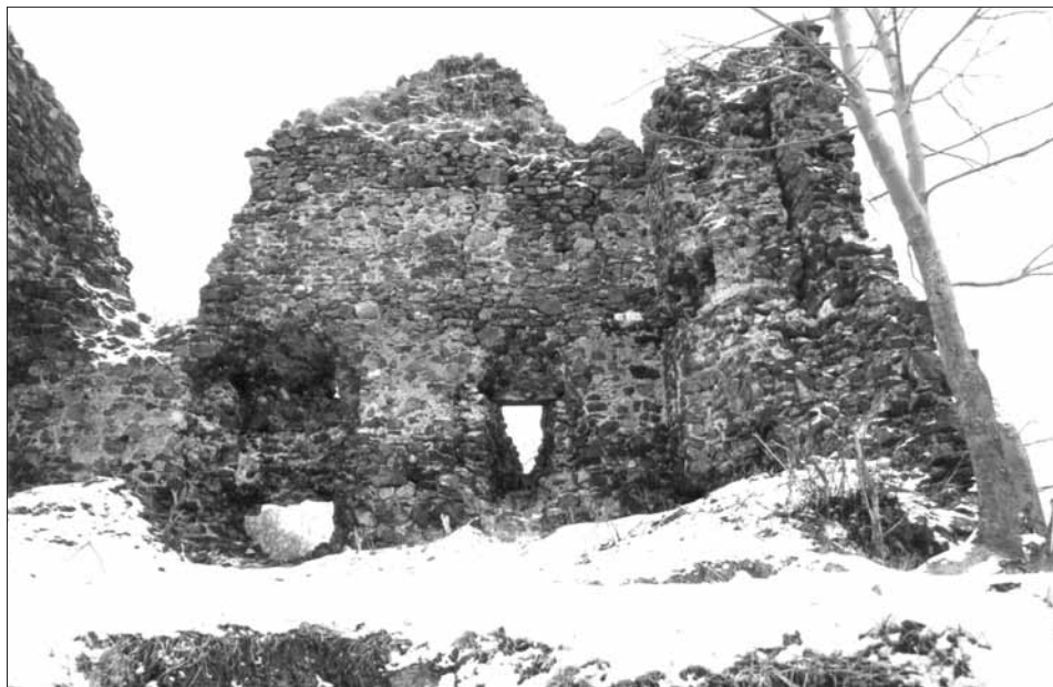
Obr. 16. Týřov, hrad. Pohled od severozápadu do bývalého interiéru věžového paláce horního hradu. Uprostřed jihovýchodní stěna se dvěma okenními otvory v přízemí (levý je nad druhotně vylámaným otvorem zazděný), vpravo jihozápadní zeď s vnitřní svislou spárou a s kapsami stropních trámů (srov. obr. 17, 18). Foto V. Razím, 2001. — Abb. 16. Burg Týřov. Obere Burg, Turmpaläs, einstiges Interieur, Nordwestansicht. In der Mitte Südostwand mit zwei Fensteröffnungen im Erdgeschoß (die linke über der sekundär durchgebrochenen Öffnung zugemauert), rechts südwestliche Mauer mit einer inneren vertikalen Baunaht und den Deckenbalkenlagern (vergl. Abb. 17, 18). Foto V. Razím, 2001.
