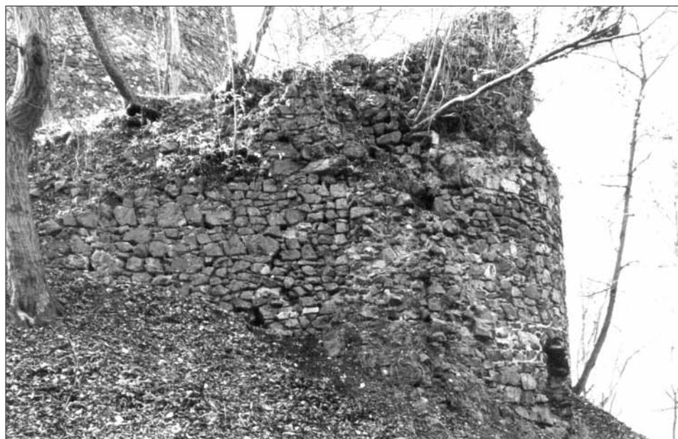
Obr. 25. Týřov, hrad. Pohled od východu na severozápadní věž dolního hradu (vpravo) a zeď příhrádku. Uprostřed relikt návaznosti zaniklé kurtiny opevnění dolního hradu. Nad tímto reliktem zbytek oblého pláště věže, k němuž byla zeď příhrádku „tečně“ na spáru přiložena. Foto V. Razím, 2001. — Abb. 25. Burg Týřov. Nordwestlicher Turm der unteren Burg (rechts) und die Zwingermauer. In der Mitte ein Relikt nach einem Anschluß der verschwundenen Kurtine von der Befestigung der unteren Burg. Darüber ein Rest vom runden Turmmantel, zu dem sich die Zwingermauer mit einer Baunaht „tangential“ anschloß. Foto V. Razím, 2001.
