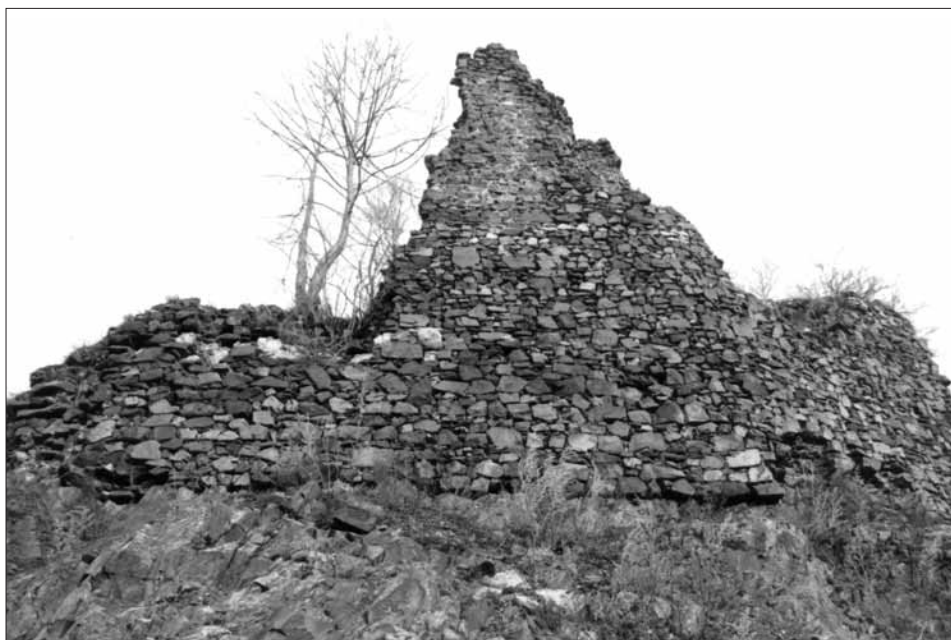
Obr. 19. Týřov, hrad. Pohled na vnější stranu jihozápadní zdi věžového paláce horního hradu. Světlé kameny ve zdivu (zejména v levé části nahoře a ve střední, vysoké části uprostřed) jsou z importované křídové horniny, používané k výrobě opracovaných architektonických prvků. Foto M. Micka, 2001. — Abb. 19. Burg Týřov. Obere Burg, Turmpalasz, Außenseite der Südwestmauer. Helle Steinstücke im Mauerwerk (besonders links oben und im hohen Mittelteil in der Mitte) sind Stücke des importierten, zur Herstellung der gemeißelten architektonischen Glieder bestimmten Kreidegesteins. Foto M. Micka, 2001.
