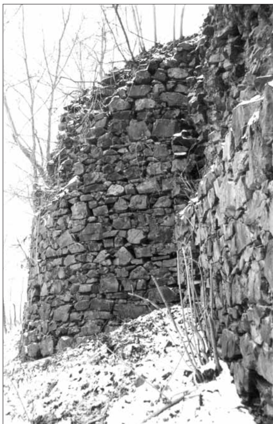
Obr. 24. Týřov, hrad. Pohled od východu na jihozápadní nárožní věž dolního hradu. Líc kurtiny (vpravo) je s pláštěm věže provázaný, na horní části věže však nebyla vazba provedena. Foto V. Razím, 2001. — Abb. 24. Burg Týřov. Südwestlicher Eckturm der unteren Burg, Ansicht von Osten. Das Mauerhaupt der Kurtine (rechts) ist mit dem Turmmantel verbunden, am Oberteil des Turms wurde die Verbindung nicht ausgeführt. Foto V. Razím, 2001.
