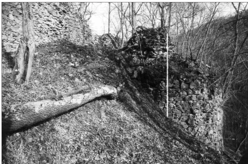
Obr. 23. Týřov, hrad. Jihozápadní nárožní věž dolního hradu v pohledu od západu. Vlevo nahoře jižní zeď horního hradu s reliktem hranolového pilíře (srov. obr. 11). Snímek umožňuje představu o značném výškovém rozdílu mezi základy věže dolního hradu a zdi horního hradu (lať u věže je dlouhá 4 m). Vodorovné technologické spáry zdiva věže dokládají, že výstavba této části opevnění dolního hradu byla zahájena věží a ukončena připojením kurtiny (v nadzemní úrovni zanikla) k pilíři horního hradu. Foto V. Razím, 2002. — Abb. 23. Burg Týřov. Untere Burg, südwestlicher Eckturm, Westansicht. Links oben Südmauer der oberen Burg mit dem Relikt des quadratischen Pfeilers (vergl. Abb. 11). Die Aufnahme vermittelt eine Vorstellung von dem beträchtlichen Höhenunterschied zwischen den Fundamenten des Turms der unteren Burg und der Ringmauer der oberen Burg (die Latte am Turm ist 4 m lang). Horizontale Lagerspalten im Turmmauerwerk beweisen, daß der Ausbau dieses Teils der Befestigung der unteren Burg mit dem Turmbau begonnen hatte und mit dem Anschluß der (in überirdischen Teilen verschwundenen) Ringmauer an den Pfeiler der oberen Burg abgeschlossen wurde. Foto V. Razím, 2002.
