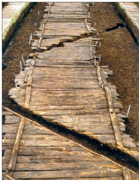
Obr. 6. Hačovaná cesta (tzv. Bohlenweg) postavená přes mokřiny u Oltmannsfehnu v severozápadním Německu okolo roku 750 př. Kr. (dle Fansa 2006 ).
