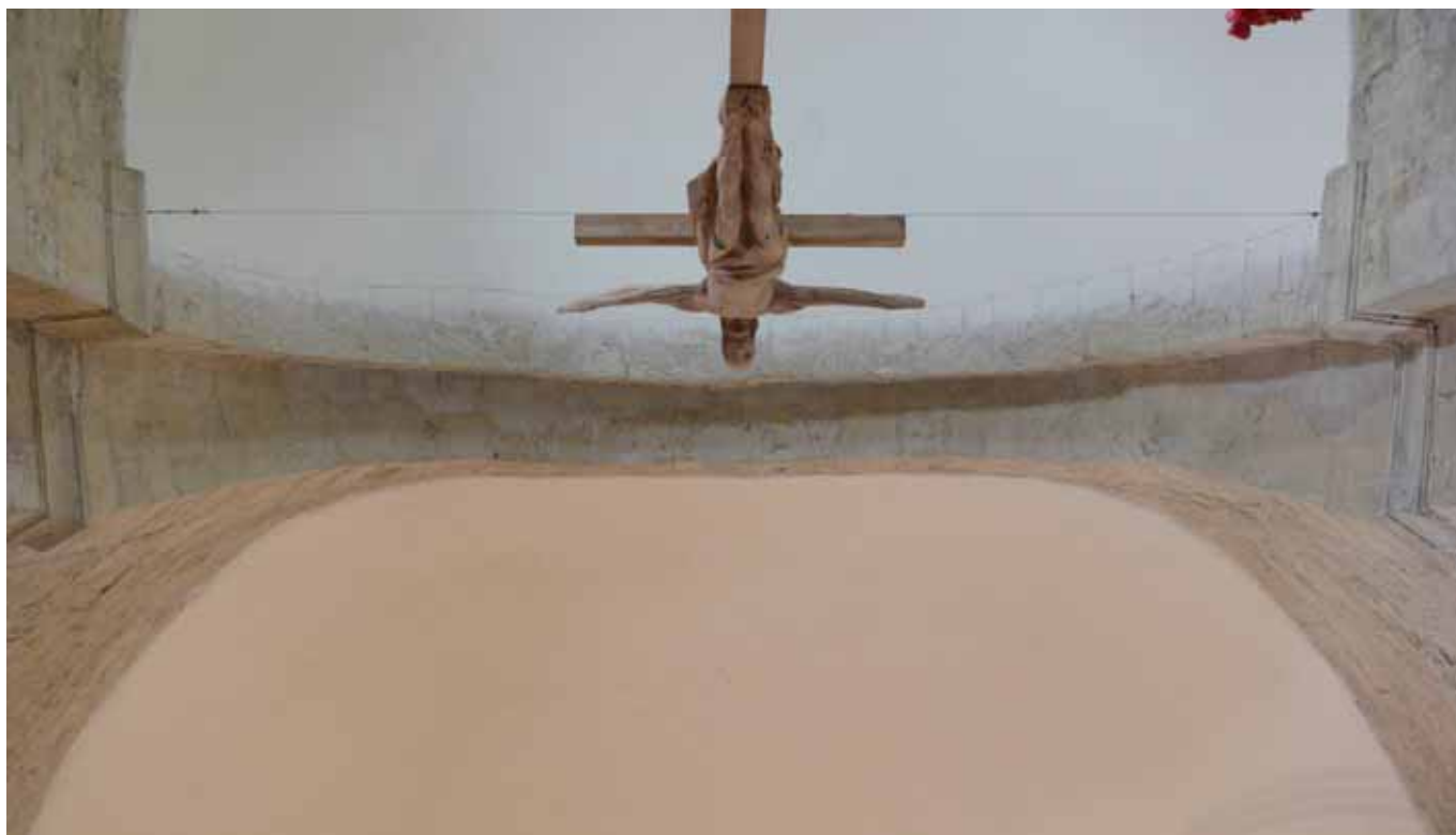
Obr. 8. 10 – Rotunda sv. Jiří, vítězný oblouk z podhledu, současný stav. Foto K. Nováček Fig. 8.10 – Saint George's, victory arch from bottom view, present state. Photo by K. Nováček.
