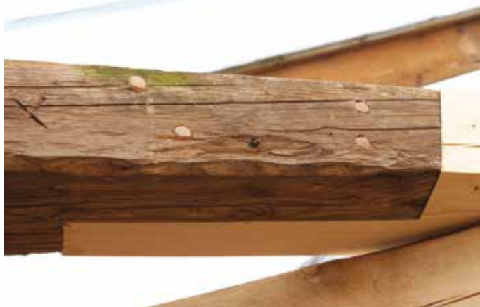
Použití celodřevěného spoje při opravě krokví na zámku v Bratronicích
