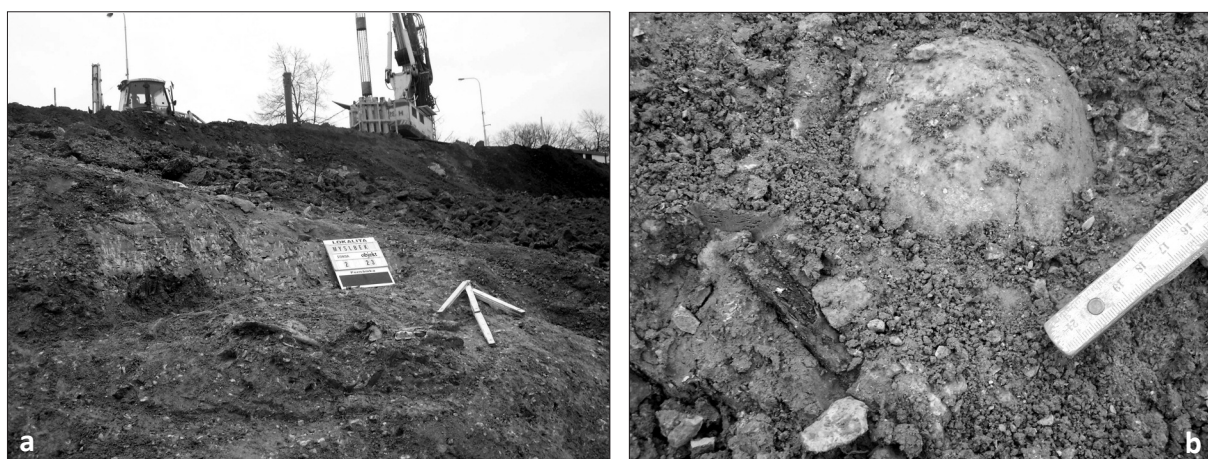
Obr. 6. Stavební jáma Myslbekova, a, b – obj. 23
