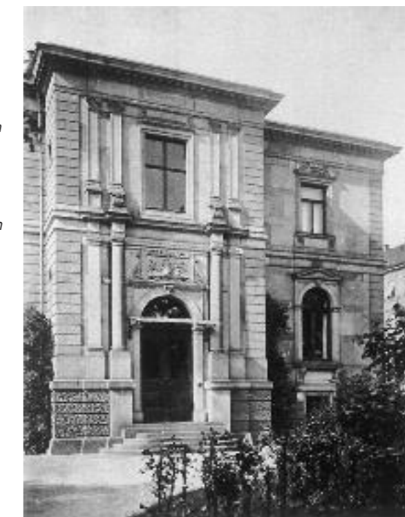
Symetrické průčelí vily Struve v Drážďanech, kterou Hermann Nicolai zbudoval v letech 1851–1852 (zničena v roce 1945). Průčelí odkazuje na italskou architekturu druhé poloviny 16. století m.j. hierarchií pilastrů a sloupů, které v přízemí zdůrazňují osu stavby – sloupy jsou blíže ke středu, po stranách jsou umístěny ploché pilastry. Stejným způsobem je zdůrazněna tektonická struktura stavby – „těžké“ sloupy jsou pouze v přízemí, v patře nad nimi jsou „lehké“ pilastry.
