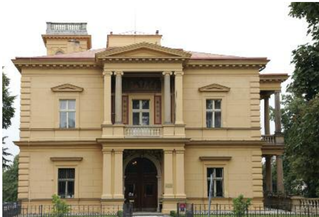
Uliční průčelí Lannovy vily, jejíž středový rizalit je variací rizalitu vily Struve v Drážďanech. Hlavní rozdíl je, že vchod v přízemí lemují pilastry, zatímco sloupy stojí nad nimi. Nad tympanonem rizalitu Lannovy vily je vidět zděný sokl střešního okna osvětlujícího horní patro haly, nalevo vrchol věže.
