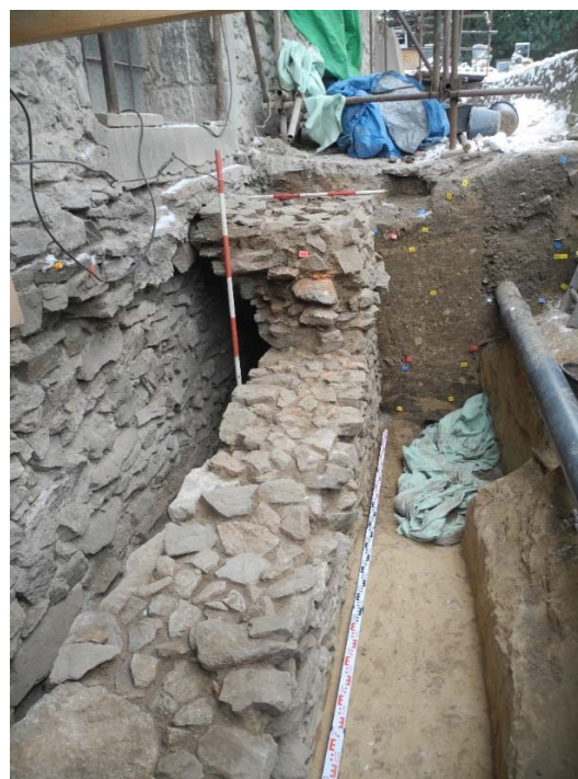
Obr. 2. Východní strana kostnice, sektor 30. Zdivo nejstarší úpravy, která měla odvlhčit základy kostnice v úseku za oltářem. 18.–19. století. Foto P. Kindelmann
