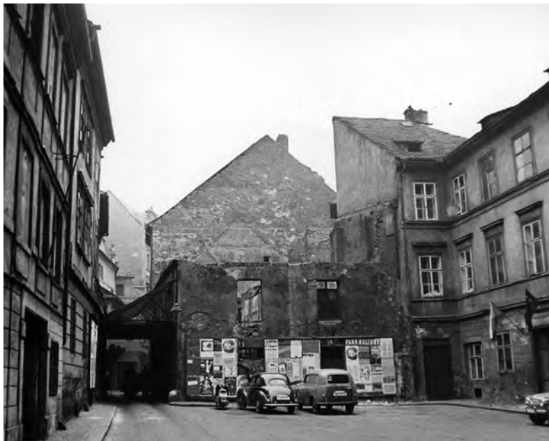
Obr. 29. Pohled do Jilské ul. s domy čp. 361 (uprostřed) a čp. 236 (vpravo). Stav před rekonstrukcí. Datace přibližně r. 1964. (Správa budov AV ČR)
