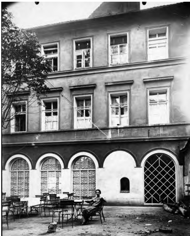
Obr. 22. Pohled do dvora domu čp. 236 z 19. 9. 1926 před přestavbou a po adaptaci jižního traktu pro obchod se starožitnostmi. Aut. Alexander. (AHMP)
