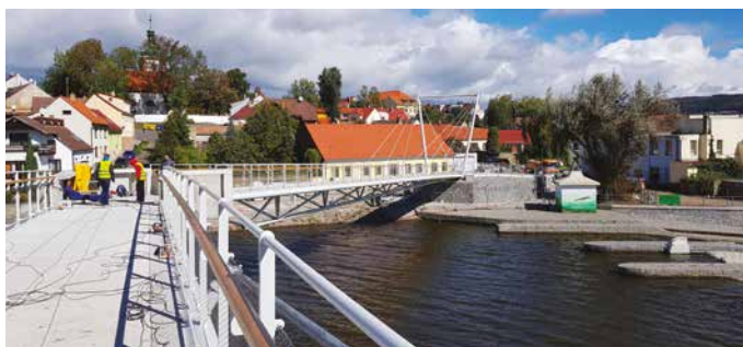
Lávky v Písku během dynamické zatěžovací zkoušky
