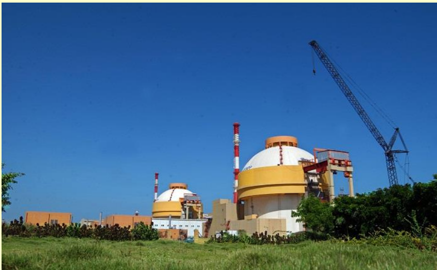
Vnější vzhled kontejnmentu VVER1000, elektrárna Kudankullam (blíží se III. generaci)
