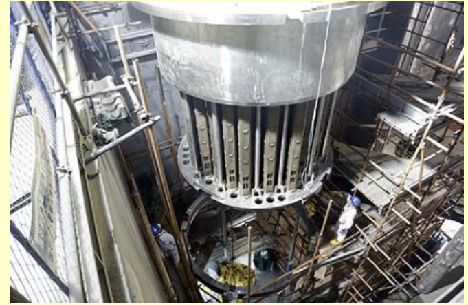
Vnitřek reaktoru – instalace Sanmen I
