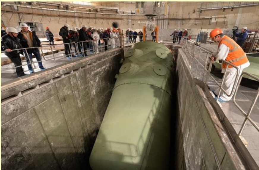
Instalace reaktorové nádoby bloku Rostov 3 (VVER 1000) Bloky VVER1000 Kudankulam Indie
