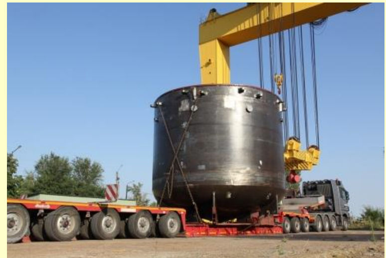
Lapač aktivní zóny bloku VVER1200 (elektrárna Ostrovec, Bělorusko)
