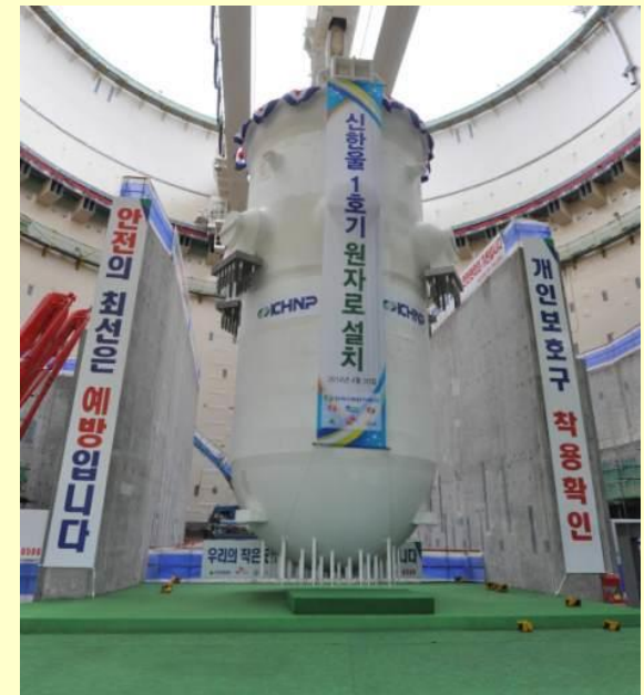
Instalace reaktorové nádoby prvního bloku nové elektrárny Shin Hanul (Jižní Korea)
