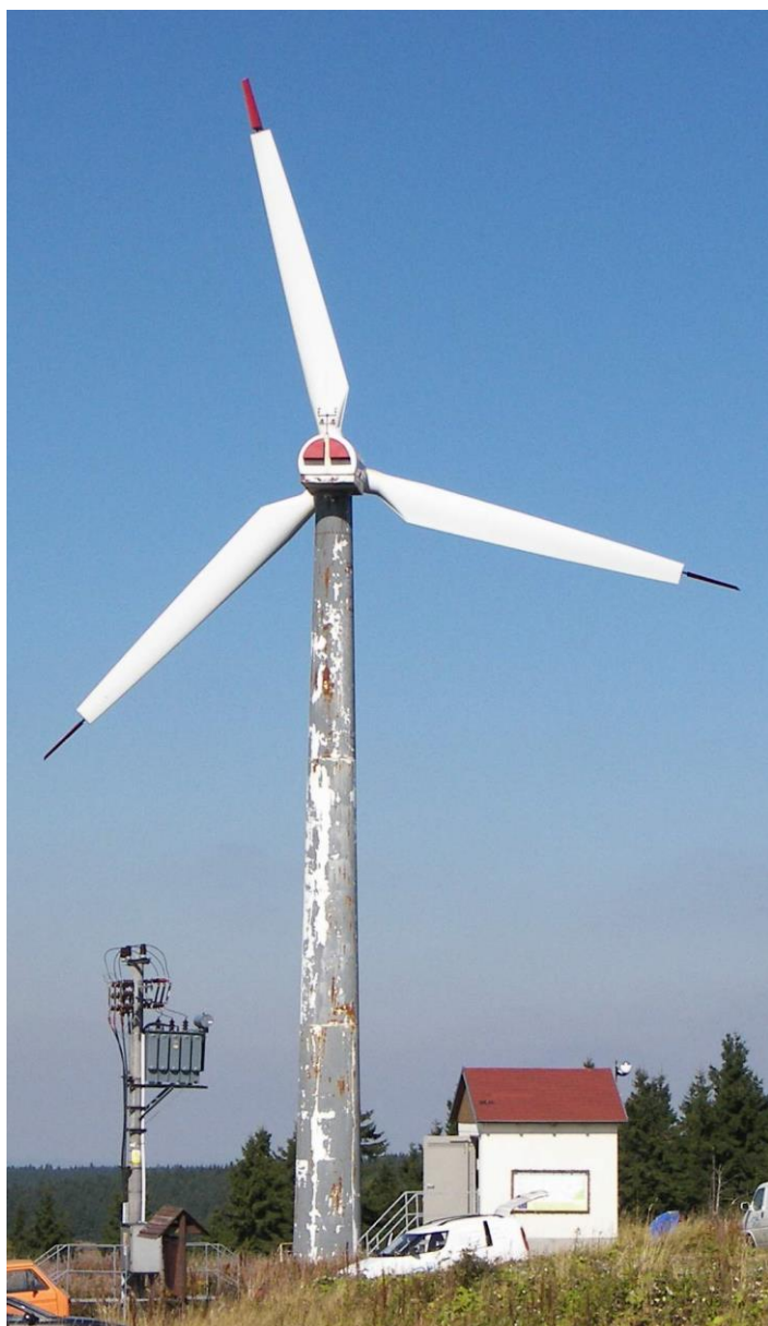
Obr. 4.3 Jedna z posledních "historických" větrných elektráren z počátku 90. let. Jde o elektrárnu EWT-315 o výšce a průměru rotoru okolo 30 m a výkonu 315 kW, která byla vyrobena jako prototyp českou firmou ENERGOVARs. Původním účelem se jednalo o experimentální větrnou elektrárnu Ústavu fyziky atmosféry na Dlouhé Louce v Krušných horách. Po několika letech občasného provozu byla prodána a přemístěna na Neklid u Božího Daru, kde donedávna přесlужovala vedle svých mladších a elegantnějších sousedek.
