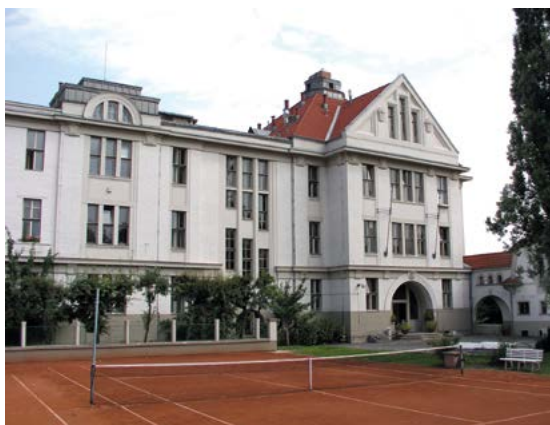
FZÚ AV ČR – pracoviště Cukrovarnická 10 v Praze 6
