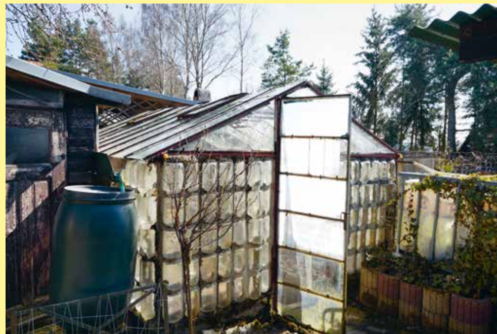
Lahve od okurek bývaly žádaným materiálem na výstavbu skleníků (foto: autorský tým)
