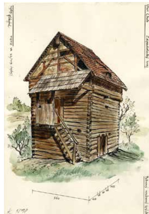
Patrový (věžovitý) roubený špýchar s hrázděným štítem (Kopanina, č.p. 16), stavba typická pro tzv. lidovou architekturu na Chebsku (zdroj: Archiv EÚ AV ČR, inv. č. K 1598, kolorovaná perokresba Josef. V. Scheybal, 1965).
